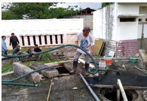
汚泥引き抜き作業 (Malakasari)
