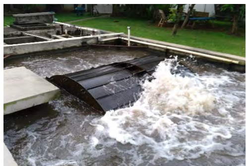
曝気/Bio Filter 処理の状況 (Malakasari)
