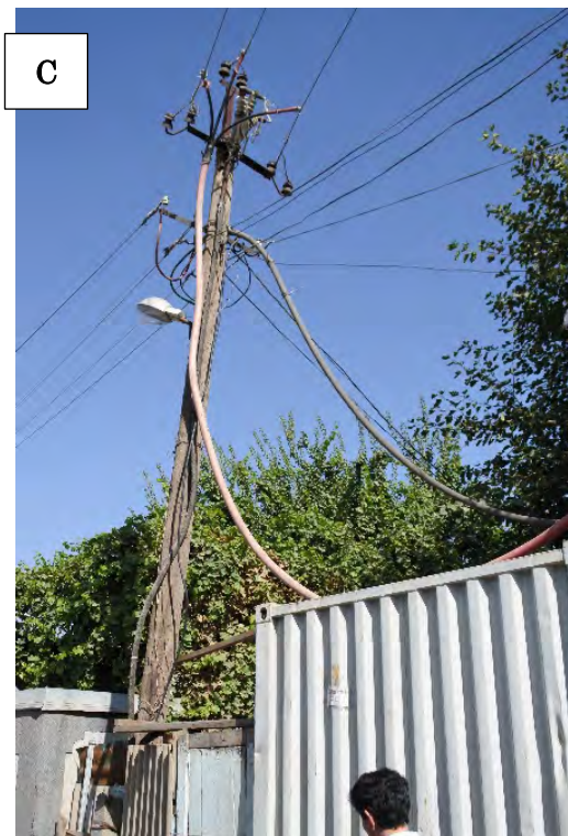
別添図 7-2 ドウシャンベ内の配電線施設状況
