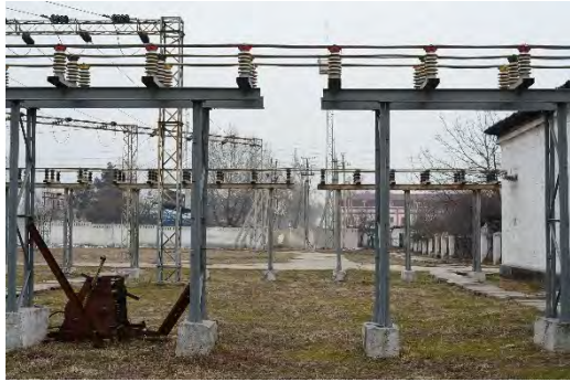
10kV スイッチギヤ・制御室建屋予定地
