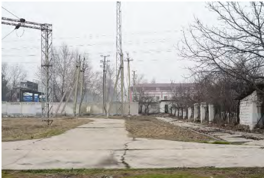
撤去品仮置き場
