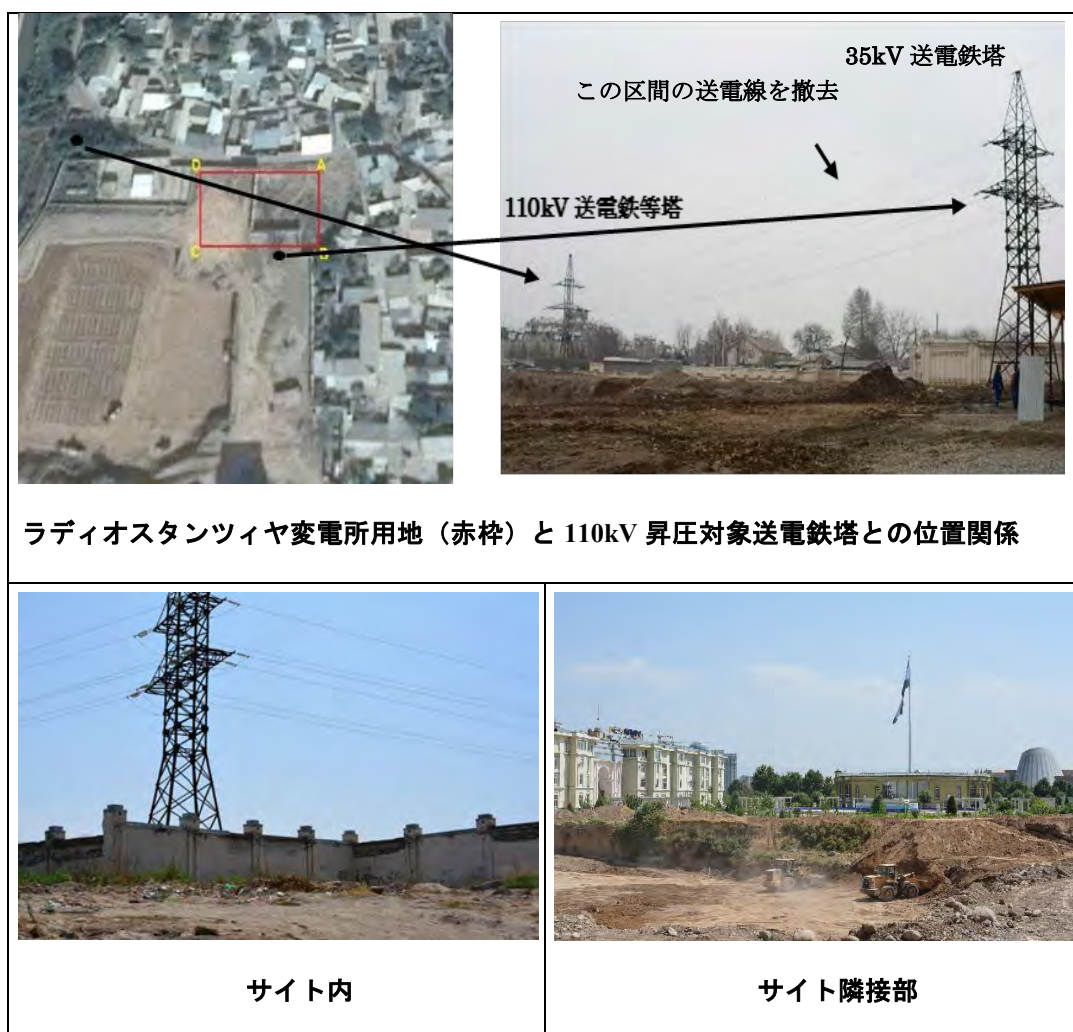
図 3-2 ラディオスタンツィヤ変電所予定地と周辺の状況
