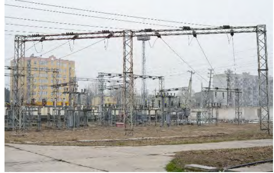
35kV スイッチギヤ・建屋予定地
