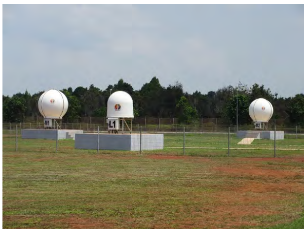
写真 1-11 衛星を介した遭難信号を受信するアンテナ（Local User Terminal : LUT）。AMSAS 構内に設置されている
