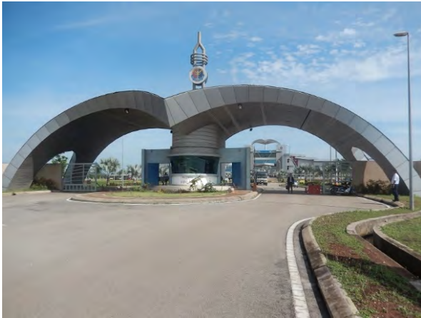
写真 1-1 AMSAS メインゲート。この向こうに約0.8 平方キロメートルの敷地が広がる
