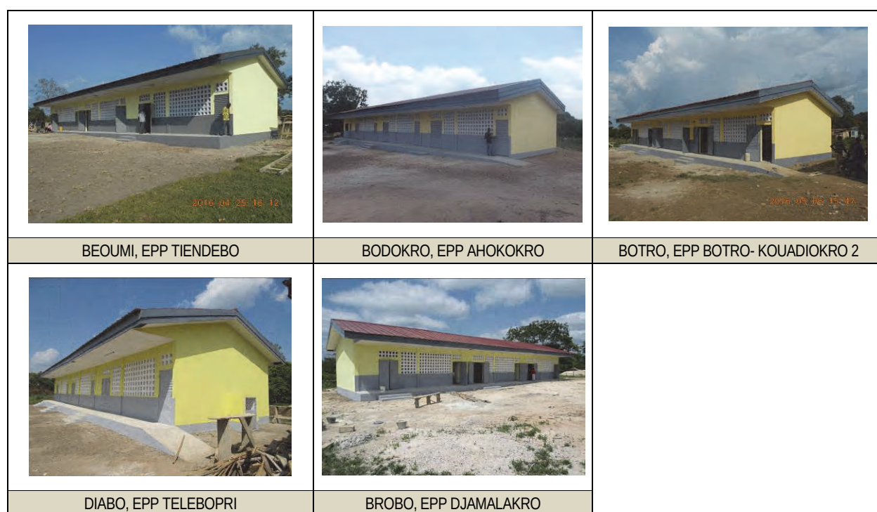
Figure 4.2.1 Construction de Bâtiments d'Ecoles
