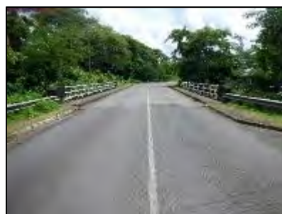
写真 2-2-8 レラタ橋全景(正面)
