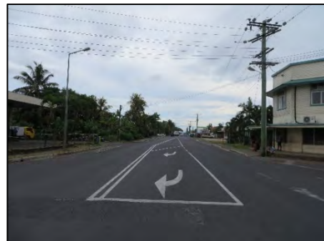
写真 2-2-12 マタファガテレ道路（競技場付近）
