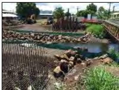
写真 2-2-4 工事状況(全景)
