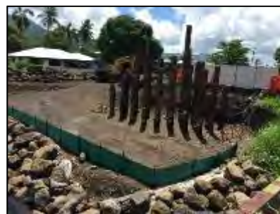
写真 2-2-5 橋台 H 杭打設状況
