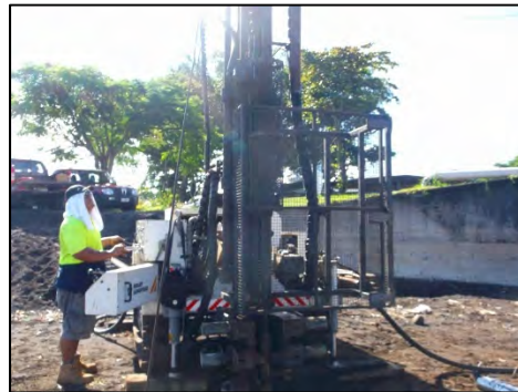
写真 2-2-23 陸上部 (A2) N 値観測状況
