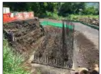
写真 2-2-6 橋台 H 杭打設状況
