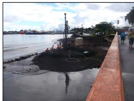
写真 2-2-25 河道部 (P2) ボーリング調査状況
