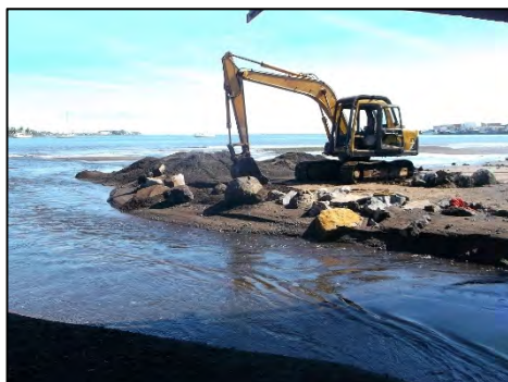
写真 2-2-24 河道部 (P2) ボーリング箇所埋土状況
