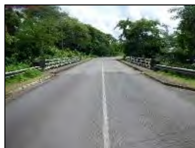
写真 2-2-8 レラタ橋全景(正面)
