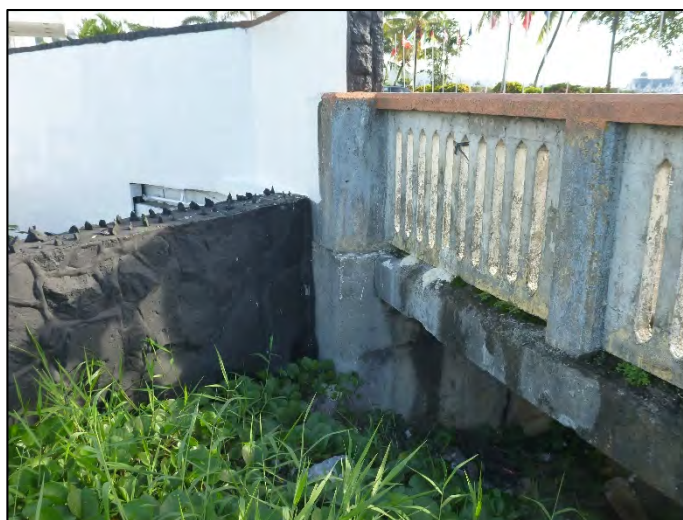
図 3-2-26 堤防と既設橋橋台の状況
