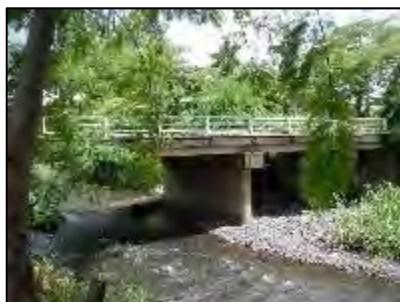
写真 2-2-7 レラタ橋全景(側面)
