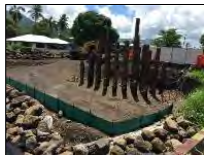
写真 2-2-5 橋台 H 杭打設状況
