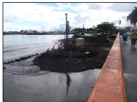
写真 2-2-25 河道部 (P2) ボーリング調査状況
