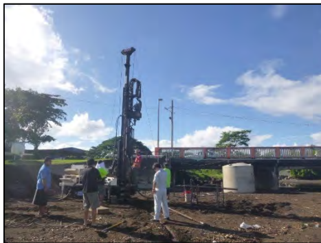
写真 2-2-22 陸上部 (A2) ボーリング調査状況
