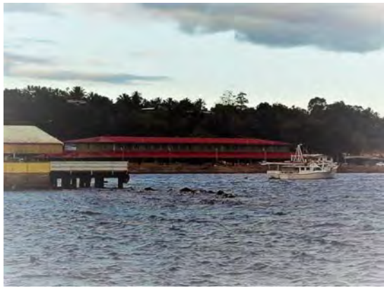
トランジット・ハウス (ミルンベイ州各地域住民の簡易宿泊施設)
