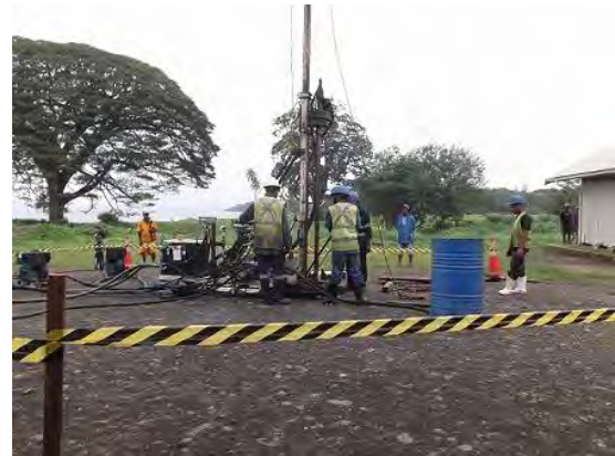
プロジェクトサイト中央部 (地質調査)
