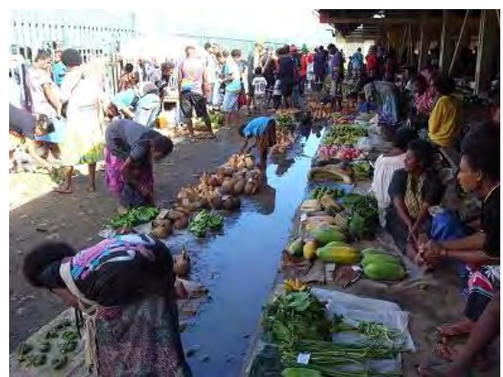
売場棟②東側露天 (降雨後の売場)
