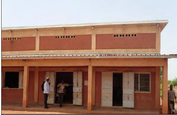
9 ブルキエнде県チオウ・コミュニン YARGO 小学校：日本支援「第2次小学校」教室棟が活用されている。
