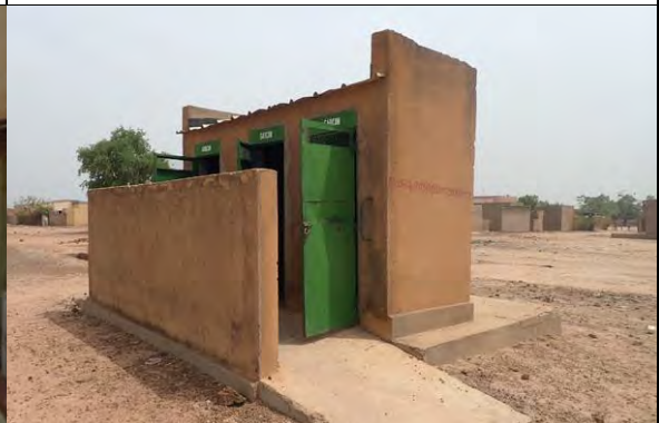
28 同左 (世銀支援)。男子便所棟。4 教室中学校の標準設計は男女別棟 (3 ブースずつ) となっている。
