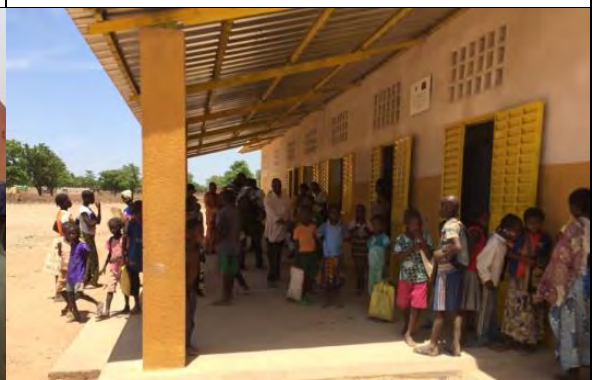
32 第 5 次小学校教室棟の屋根付きテラス。多目的に利用され先方政府からの評価が高いことから本案件でも同様のテラスを設ける。
