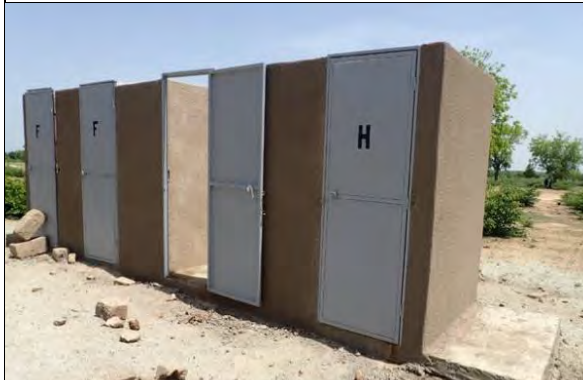
29 AZAO 支援による中学校の男女共通の便所棟 (2 ブースずつ)。屋根はない。
