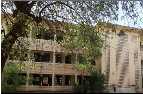
17 カディオゴ県 Lycee Phillipe Zingda Kabore : 3階建校舎、70 教室。ワガドゥグ市は複数階の中学校校舎建設を推進している。
