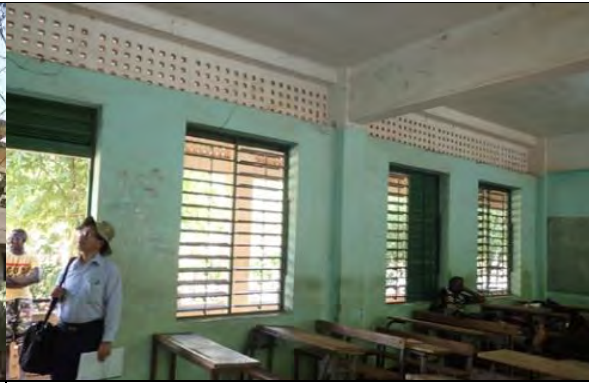
18 教室内観。ブルキナファソ国最大の公立リセであり、教室内部も 76 m 2 程度と広く、天井が高い。照明あり、換気扇なし。
