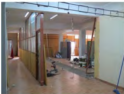
GDMR 内で大掛かりな改装工事が実施中 右手奥の一角がサーバルーム (右写真) の予定
