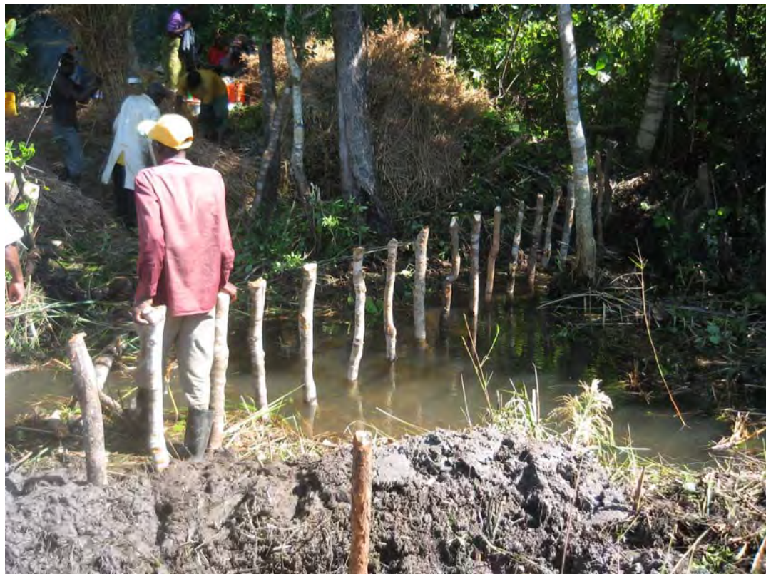
取水堰の建設状況の一例である。写真は一列に打ち込みが終了した木杭を示しているが、この後に木杭の間を草で編み込みながらフェンスを建設していく。
