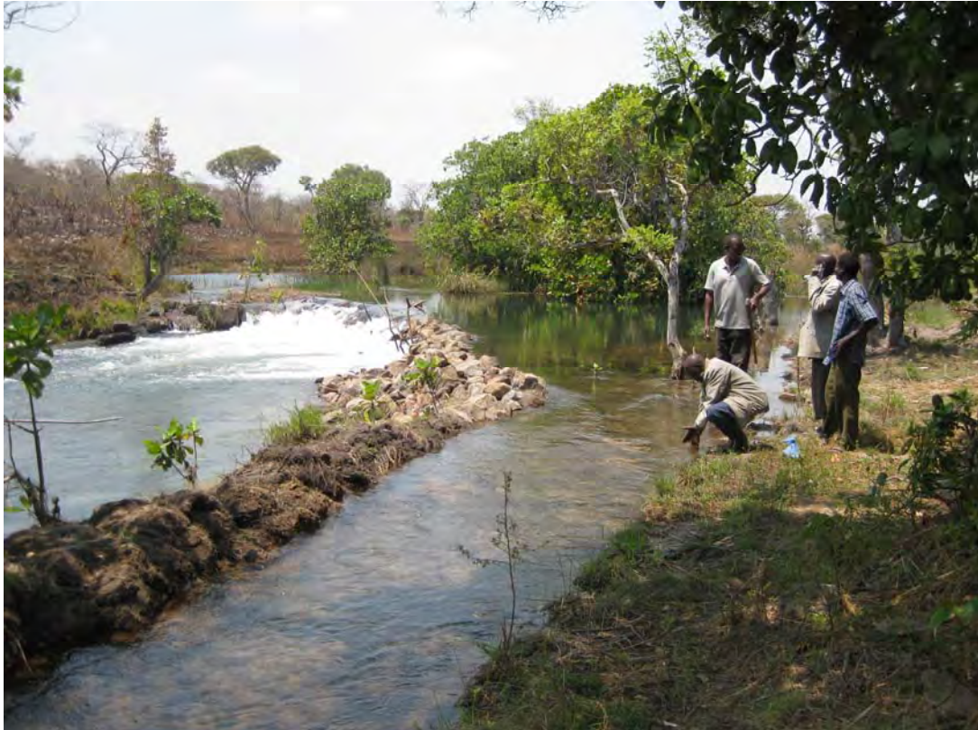
北部州、Kasama 郡 Chiponpo サイトの水路である。河川本流の段差部直上流にて簡易の石積み堰を建設したことで、水位標高を有効に利用しながら取水している。用水路の本体規模は幅およそ 2m、深さおよそ 60cm であり、建設地周辺に存在する岩、石、土などを利用して建設されている。
