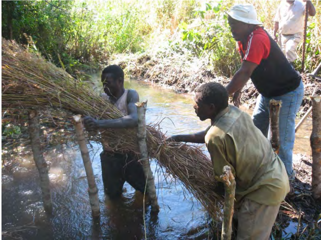
木杭の間を草で編み込みながらフェンスを建設していく。草は直径 20cm～25cm 程度に束ね、木杭間を縫うように、一層ずつ積み上げていく。
