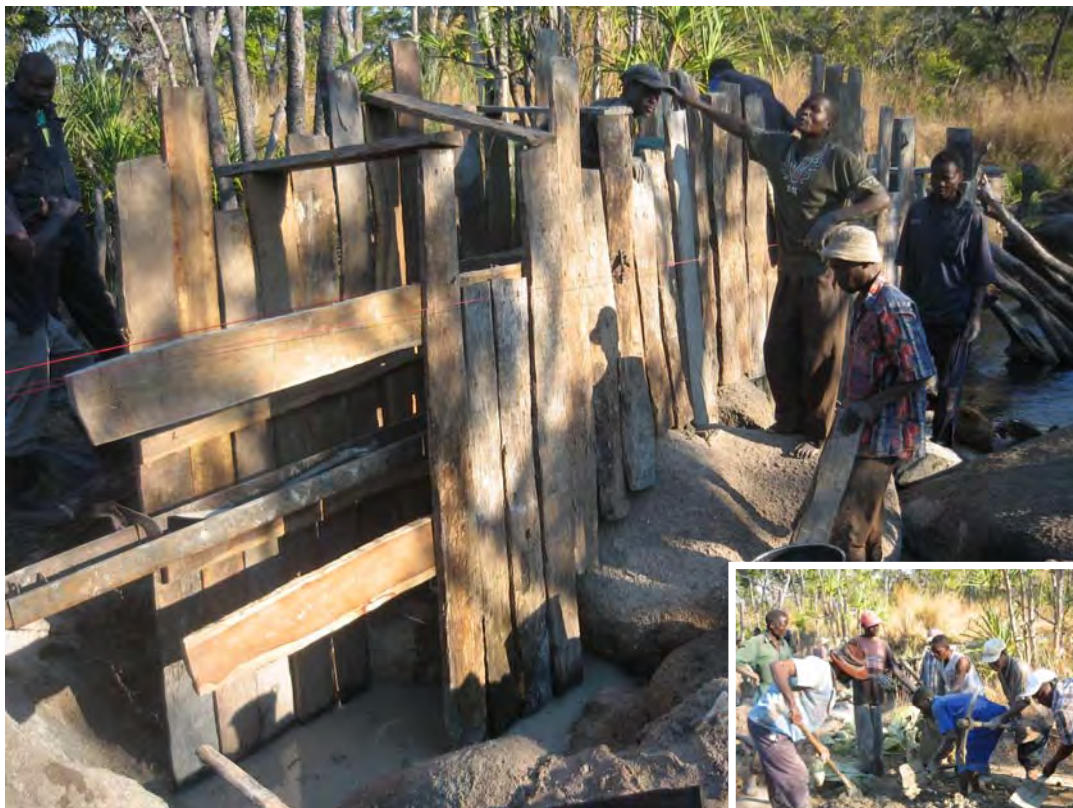
コンクリート打設前の型枠設置作業の様子を示している。こうしたコンクリート工事に関して、JICA 調査団、そして郡 TSB 職員や州灌漑技師らによる農民への技術的支援を行っている。写真右下はコンクリート練り混ぜ作業の状況である。
