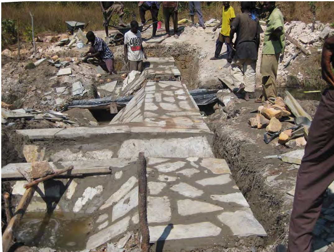
練石積みタイプの恒久堰である。本堰は中央に余水吐を設置し、右岸・左岸の両岸取水としている。水路の取水部から20m程度は湾曲部があり侵食が予想されることから、土水路ではなく練石積み水路として建設している。
