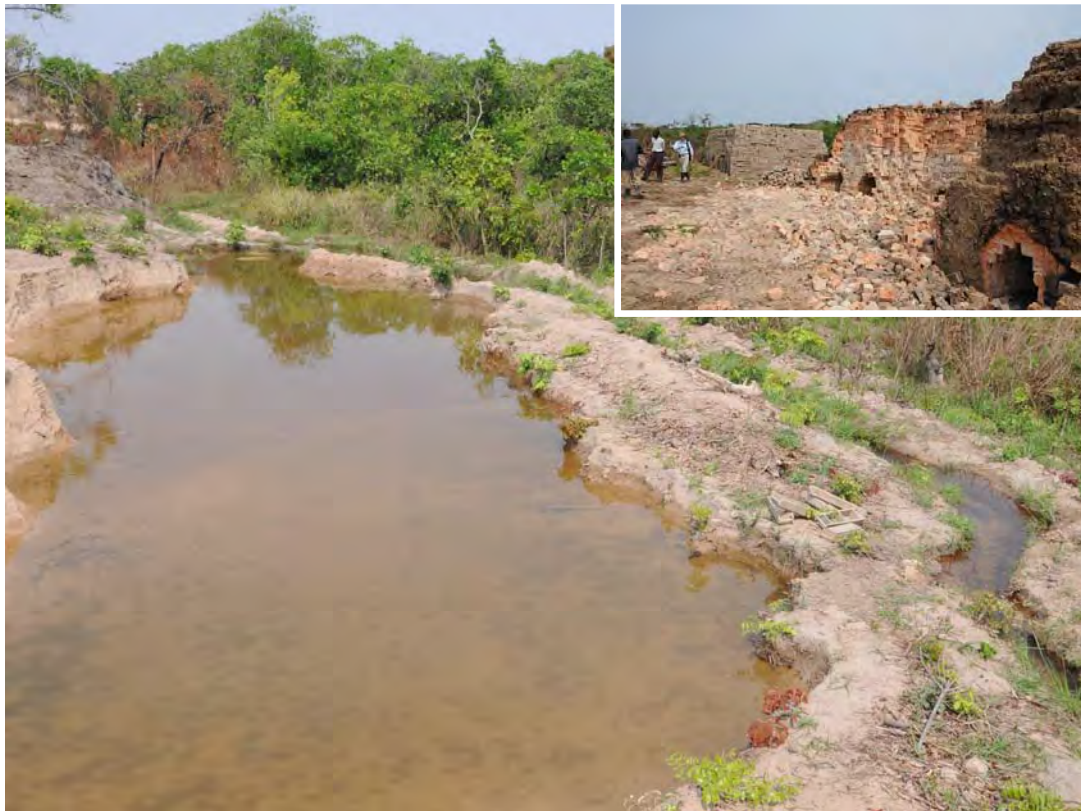
ザンビア国では小学校建設にあたって、コミュニティから労務、砂利、さらにブリックの提供が行われている。灌漑水路沿いの良質の粘土が水路の水を利用して最適な含水比に調整された後、ブリックが作成された例である。ここでは、約15万個のブリックが必要とされた。
