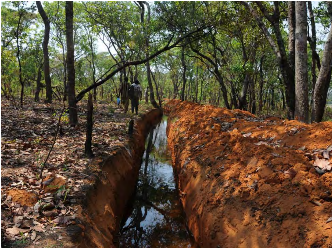
北部州、Kasama 郡内の Chabukila サイトの水路である。延長は 2km を越えるが、途中で墓地があり、これを回避するために山側に路線を変更、結果、1.5m 程度の深い掘削部分が 400m 程度にわたって連続している。この建設もすべて鍬のみで行った。
