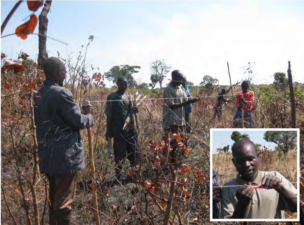
簡易堰を主体としたサイトでは普及員が普及の中心となるため、水路の線形決定にあたっても複雑な測量器具は用いないことを原則としている（普及員は測量器具の使用はできず、また、器具自体が不足している）。水路の路線決定を行うのはラインレベルと呼ばれる簡易水準器である（約3$/個）。
