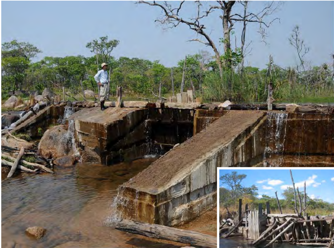
アップグレードされた取水堰（Luapula 州マンサ郡）の一例である。全幅約 44m の取水堰の原形は材や土により建設されたが、年々、コンクリート堰への改修工事が進んでいる。セメントなどの資材は農民グループならびに JICA からの提供によって調達されている。写真右下は改修工事前の状況である。
