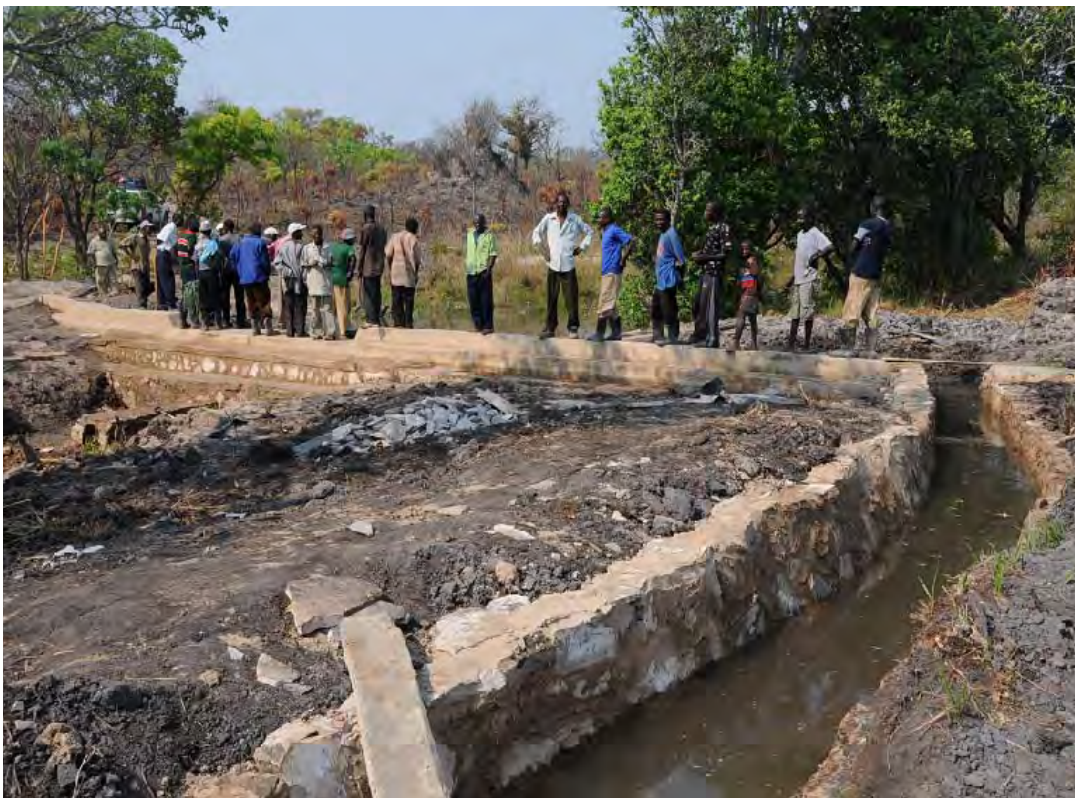
2010年9月に完成したChibolya恒久堰サイトである（ルアプラ州 Kawambwa郡）。写真右側が水路である。恒久堰によって安定した取水がなされている。本堰は2009年に建設された簡易堰からアップグレードされたものである。堰の最終仕上がり規模は、堰延長：24m、堰高：2mである。
