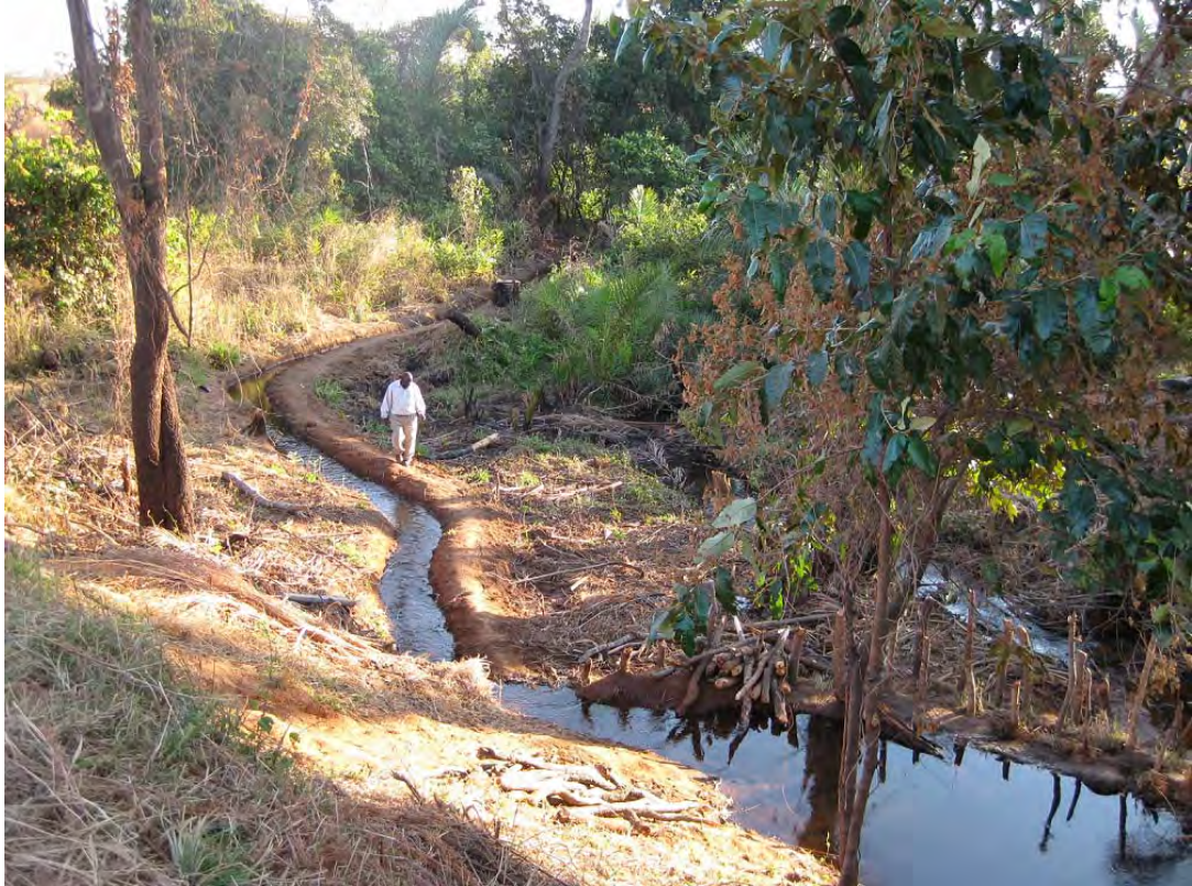
農民建設による水路の一例である。水路の掘削は、原則、農民が農作業で使用する鍬のみで行っている。等高線沿いに徐々に標高を下げながら建設された水路は重力によって、圃場まで灌漑用水を運ぶ。また、手前下右側に見えるのがシングルライン簡易取水堰である。
