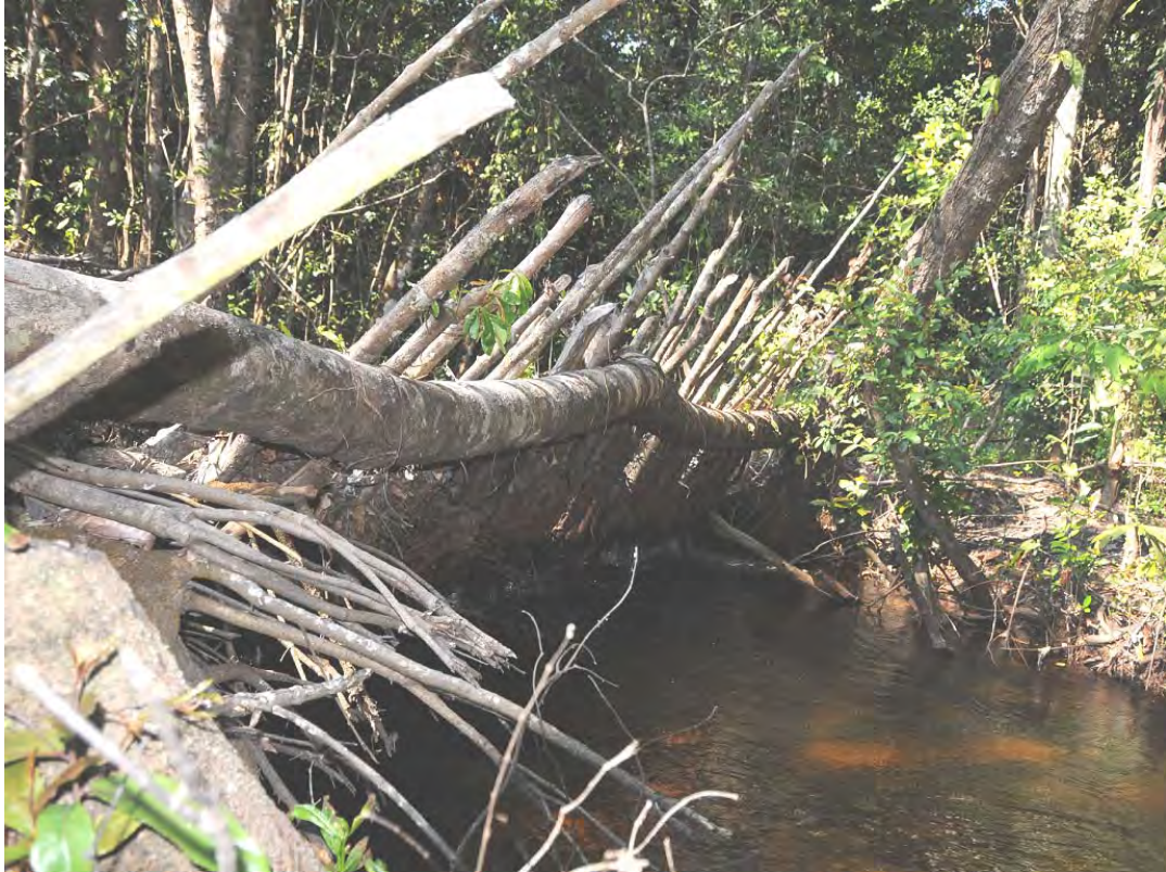
インクラインド堰と呼ばれる簡易堰である。河川幅が狭いサイトに適合する。兩岸部に大きな横木を渡し、それを支えにしながら、その前面に斜に木や竹を置き、その上に草、そして粘土を敷きつめて建設を行う。このサイトでは約 80 人が参加し半日程度で建設を終了している。
