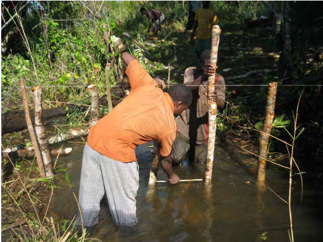
取水堰の建設状況の一例である。木杭を河床に打ち込む作業を行っている。木杭を等間隔に打ち込むため、小枝を使い間隔を測りながら打ち込んでいる。この後木杭間に流水を堰き止めるための草や葦を編みこんでいくため、木杭の間隔は 30cm 程度が適当である。
