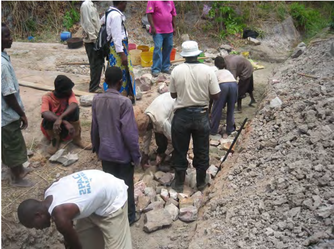
北部州 Munguwi 郡 Chibili サイトにおける用水路の道路横断工の建設状況である。横断工はモルタル練石積み造りで、幅約 70cm、深さ 50cm、道路横断幅はおよそ 12m である。写真は横断工底部の工事を行っている状況で、周辺から採取した岩、石を水路底に敷き詰めたのち、モルタルを充填している。
