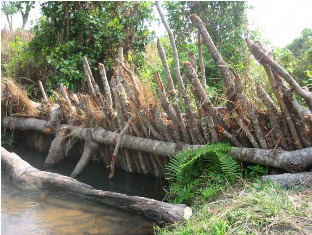
インクラインド堰の一例である。大型の横木を河川を横断して渡し、その前面に枝、草、そして粘土をいいて水位を上げている。また、横木を背面より支える支柱を 2 本ほど設置している。30 人ほどの参加で約半日で建設を終了させている。なお、材料は事前に集めたものである。
