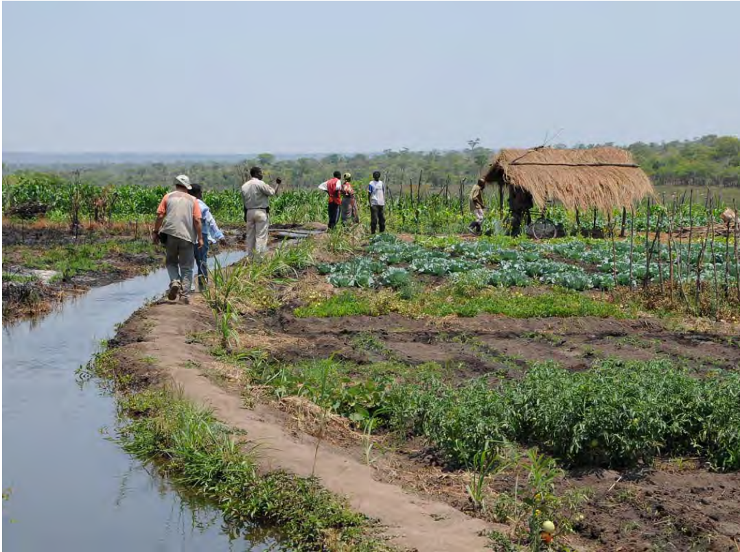
北部州 Mungwi 郡内の Nseluka サイトの水路。広大な Dambo 平原上流部に新規に設けた簡易の堰から、なだらかな丘陵地のコンターラインにうまく乗った水路の線形が伸びている。途中集落沿いを抜けさらに先へと伸びていくが、その間、水路脇では灌漑農業が営まれている。
