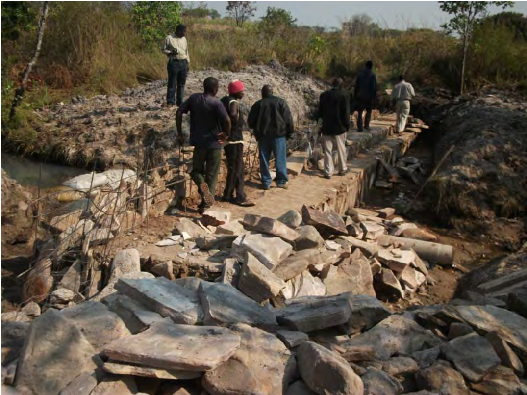
2009年に簡易堰、2010年に恒久堰へのアップグレードを行った取水堰（Luapula州 Kawambwa郡）の一例である。練石積みタイプの恒久堰である。奥に水路、中央部に余水吐、土砂吐を建設する。堰長25mの内、15m程コンクリート打設が終わっている状況の写真である。
