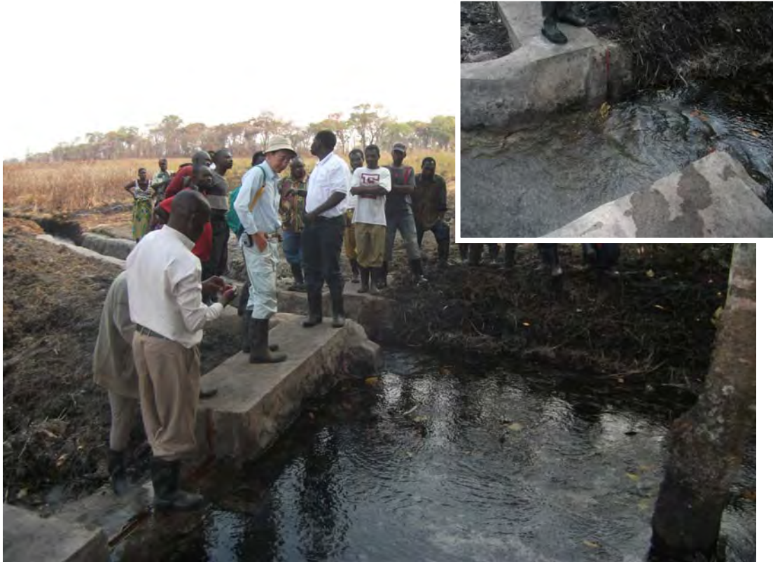
2009年に簡易堰、2010年に恒久堰へのアップグレードを行った取水堰（北部州 Luwingu 郡）の一例である。練石積みタイプの恒久堰である。奥が水路、手前が余水吐、土砂吐である。堰本体の建設が完了し、通水を開始している状況である。写真右上は水路の流下状況である。
