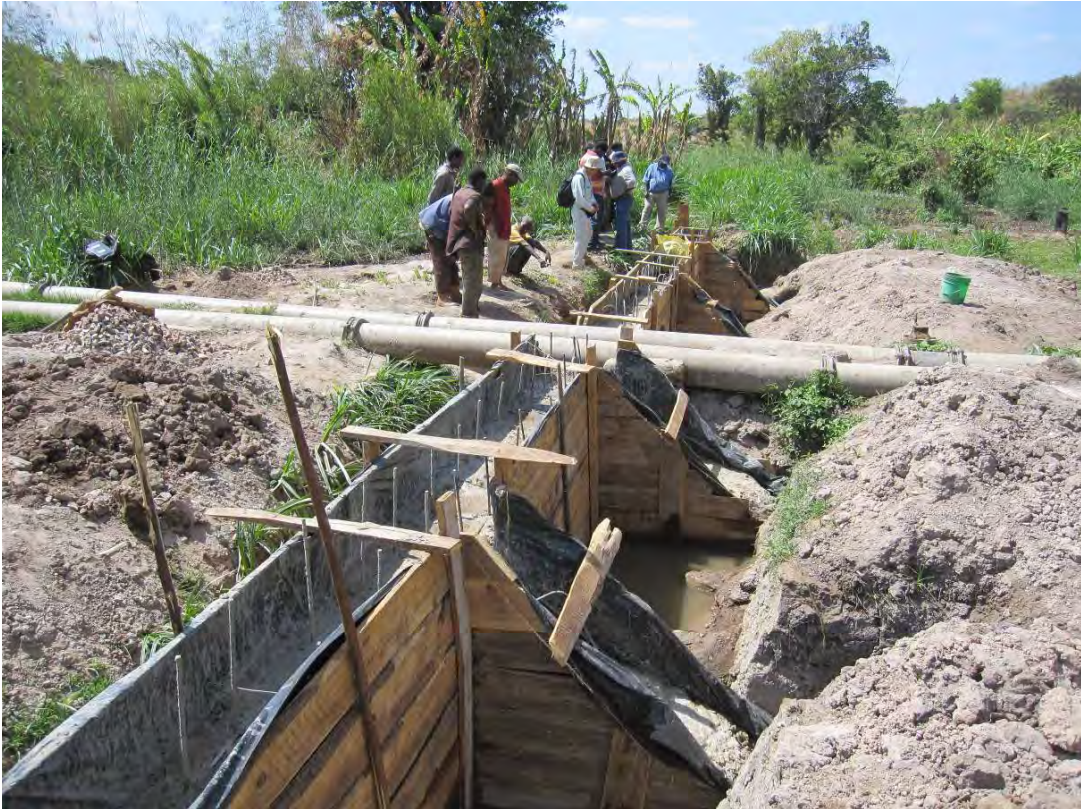
Malashi 恒久堰建設サイト（北部州 Mpika 郡）：鉄筋コンクリート造、バットレス式擁壁である。6月中旬より週2日乃至3日のペースで工事進捗している。この後、コンクリートを最終レベルまで打ち上げ、脱型、埋戻しを行う予定である。
