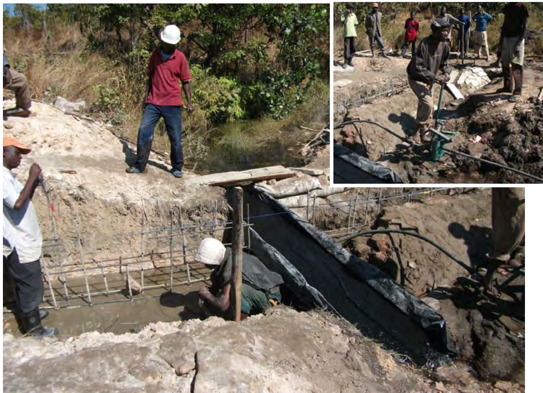
2009年に簡易堰、2010年に恒久堰へのアップグレードを行っている取水堰（北部州 Mpolokoso 郡）の一例である。コンクリート打設前の様子を示している。堰本体の掘削部に溜まる水は、足踏みポンプを使って汲み出している。写真右上は足踏みポンプ使用時の状況である。
