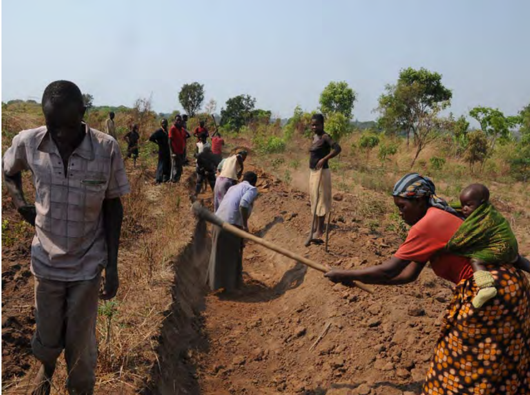
北部州、Kasama 郡内の Chabukila サイトにおける水路の建設風景である。女性を含む約 20 名が 1 週間に 2 回ほど水路掘削作業に従事している。掘削に使うのは農作業で使用する鍬、また一部ではスコップ等も用いられる。20 人程度が半日の作業で約 10～最大 25m 程の掘削が可能である。
