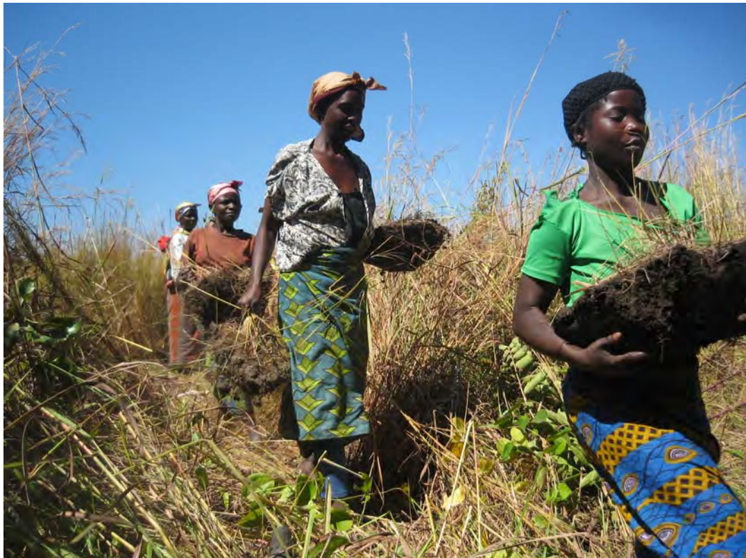
粘土は堰近傍の採取地から何度も往復して運ぶ。簡易堰建設の各工程の中でも重労働のひとつである。多くの場合、粘土の採掘には男性が、そして運搬には女性が当たっている。
