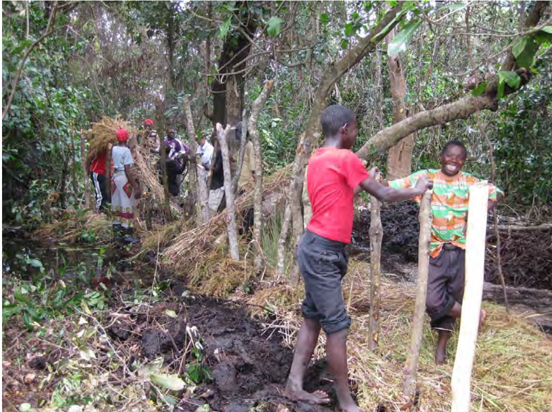
簡易堰は4種を普及しているが、写真に示すのは最も簡単なシングルライン堰である。河川を横断して木杭を一系列に打ち込み、その木杭を長けのある草（elephant grass）で縫い込み、最後に前面に粘土を貼り付けている。
