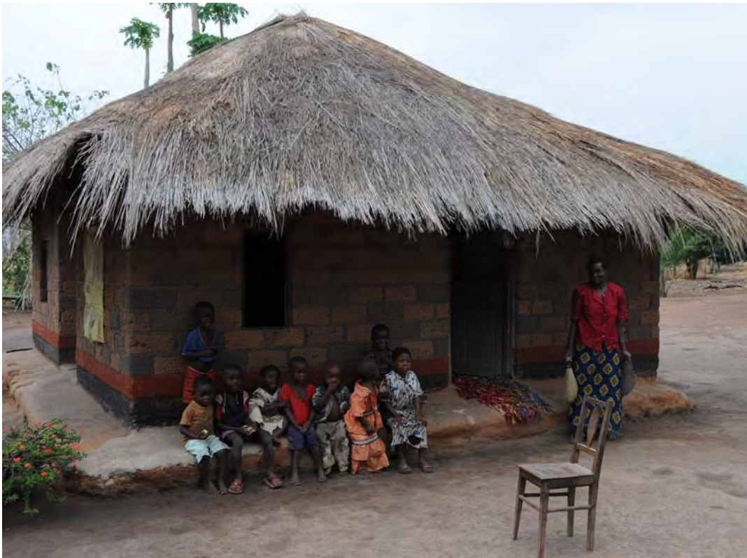
調査対象地域内に見られる代表的な家屋の一例である。多くの家屋の壁はレンガで建設されており、家屋内は通常2~3つの小部屋に区切られている。屋根は茅葺きが多いが、一部にはトタン屋根を有する家屋も見られる。なお、トタン屋根は夏場に暑くなること、また雨音がうるさいことから一般の村人には好まれない傾向がある。
