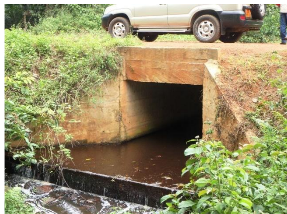
Ponceau et travaux de protection de la base
