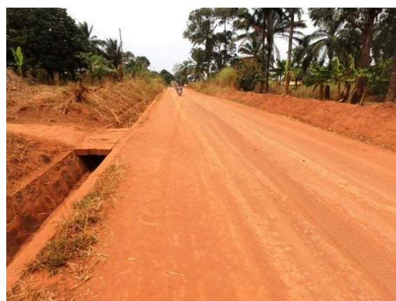
Route départementale avec fossés maçonnés (NW1)
