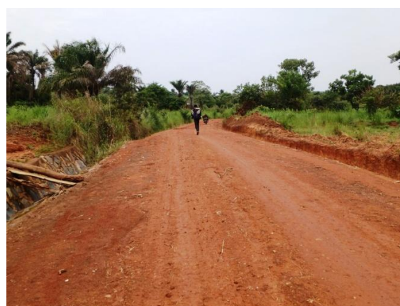
Une partie des fossés est maçonnée (partie vallonnée)
