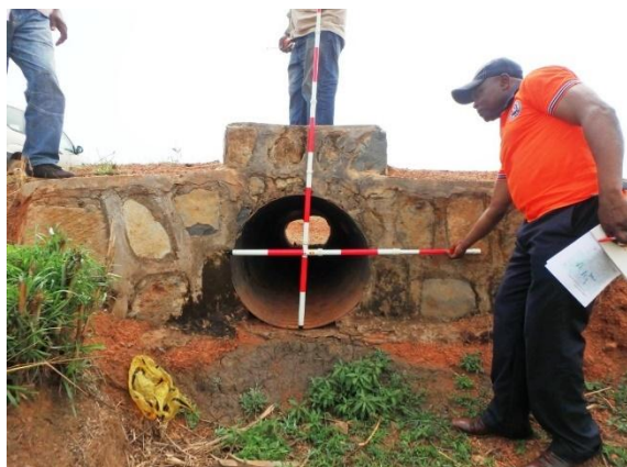
Dalots avec conduite ( \phi 800\text{mm} )
