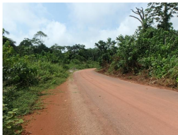
Entre Nkoetye et Ebolowa la route est revêtue d'un traitement de surface double
