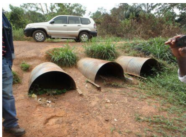
Buses dans lesquelles le passage de l'eau est bloqué par les sédiments
