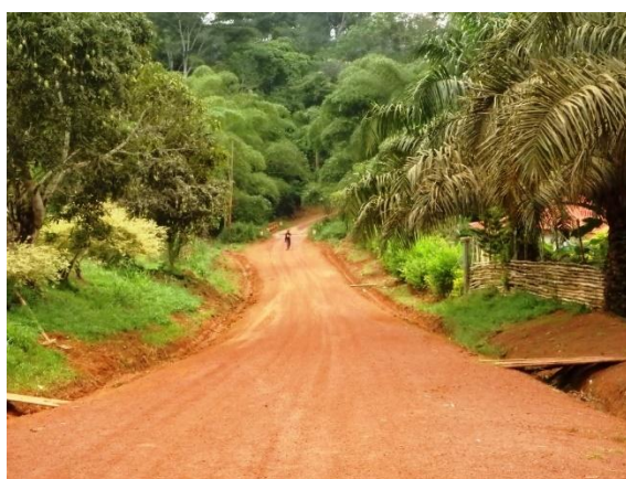
Route rurale avec fossés des deux côtés
