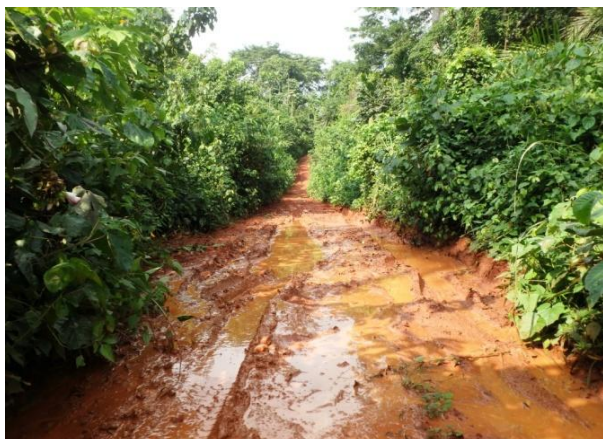
Ornières et végétations réduisent la largeur de la chaussée
