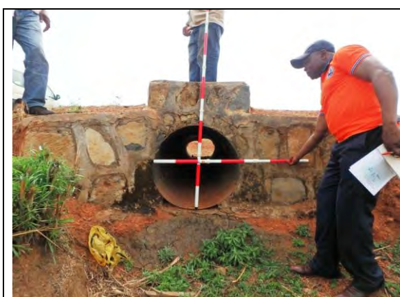
Pipe Culvert ( \phi 800\text{mm} )
