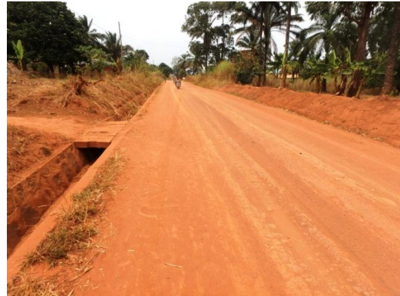
石張りコンクリート側溝を配した県道（NW1）
