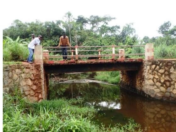
鉄筋コンクリート橋
