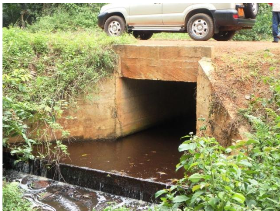
ボックスカルバートと護床工
