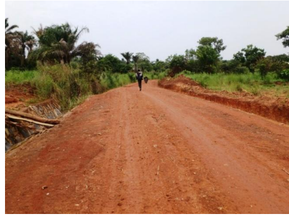
一部に石張り側溝が配されている（起伏部）
