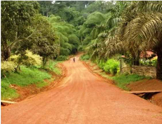
土側溝を両側に配した農道
