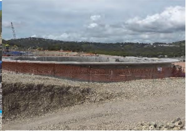
最終沈殿池#4 壁まで打設完了
