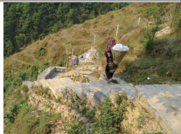
複製 VDC における水路整備サブ・プロジェクト (バグルン郡 Kahun VDC)
