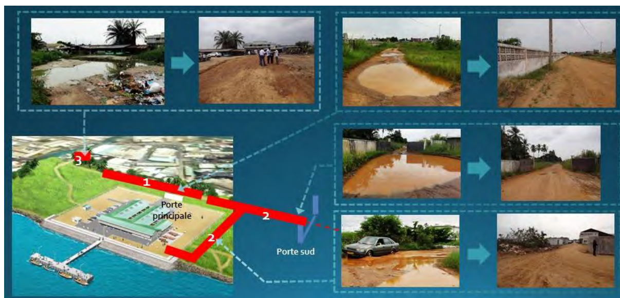
Figure 8 : Travaux d'amélioration des routes d'accès autour du CAPAL
