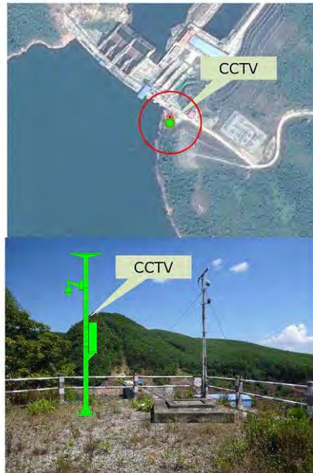
図 3-10 (9) CCTV カメラ (C9)
