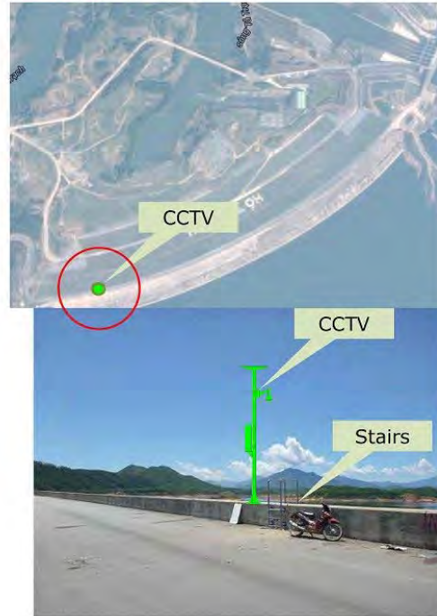
図 3-10(13) CCTV カメラ (C13)
