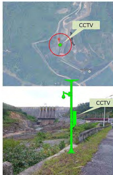
図 3-10 (10) CCTV カメラ (C10)
