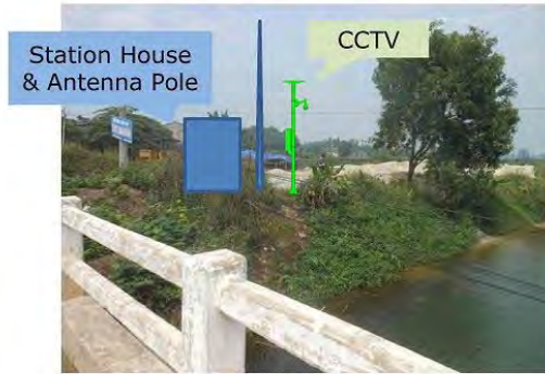
図 3-10 (5) CCTV カメラ (C5)
