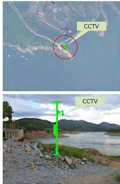
図 3-10(11) CCTV カメラ (C11)
