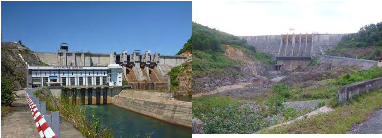
フォンディエンダム(左)とビンディエンダム(右):これら 2 つの電力ダムは、大雨が予想されるときに予備放流を行い貯水位を下げ、洪水を貯めて下流の水害を減らすこととしているが、流域の情報が無く的確に運用できていない。
