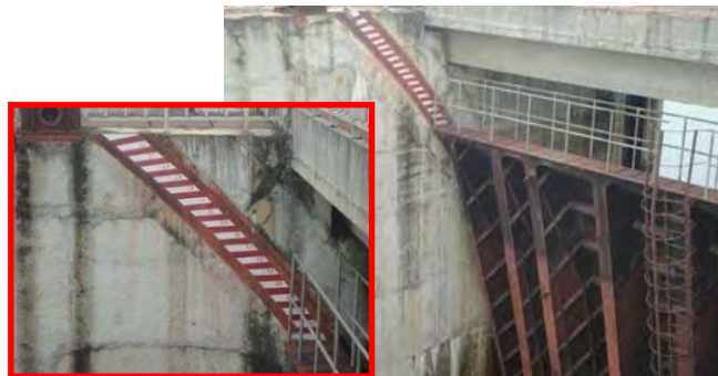
図 2-5 フォンディエンダムクレストゲート開度目盛
