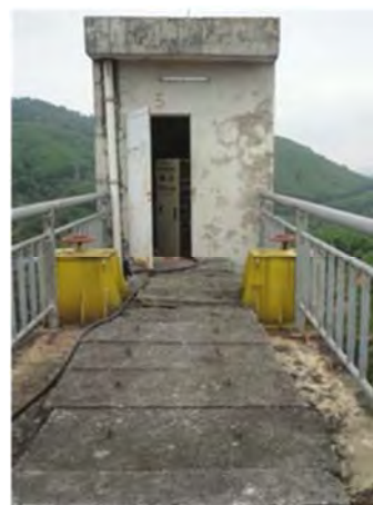
図 2-3 ビンディエンダム No.5 ゲート操作室前
