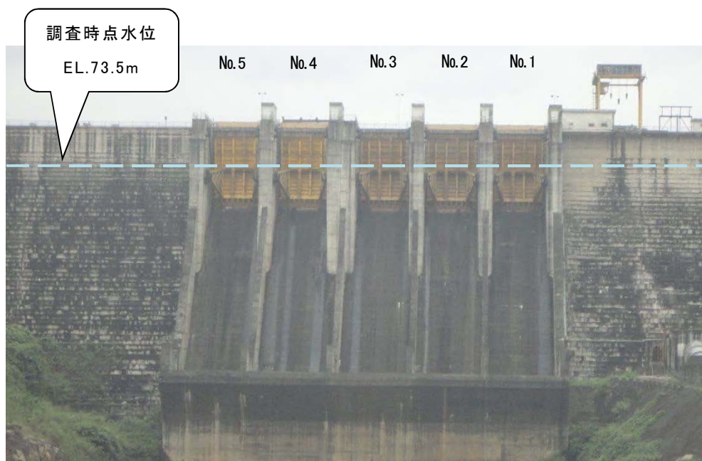
図 2-2 ビンディエンダム下流面状況
