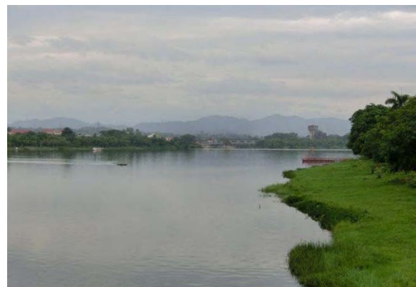
フォン川にはほとんど堤防もなく、標高 5m 以下に広がる市街地は水害に遭いやすい地形
