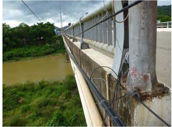
P2 水位計設置予定場所
