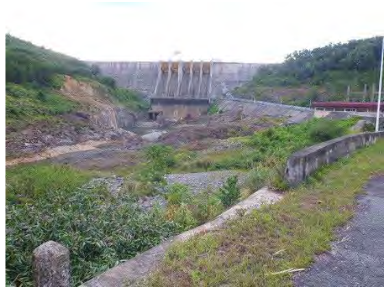
C10 CCTV 予定場所
