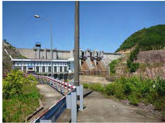
C8 CCTV 予定場所
