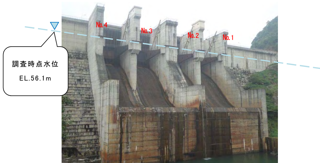
図 2-4 フォンディエンダム下流面状況
