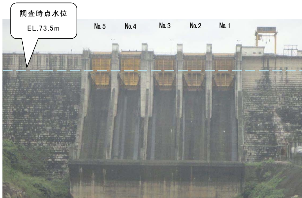
図 2-2 ビンディエンダム下流面状況
