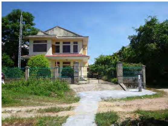
C3 CCTV 予定場所
