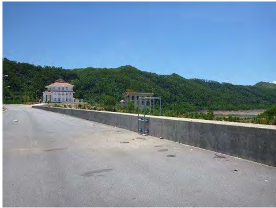
C13 CCTV 予定場所
