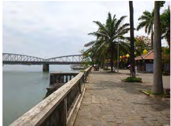
C2 CCTV 予定場所
