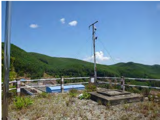
C9 CCTV 予定場所
