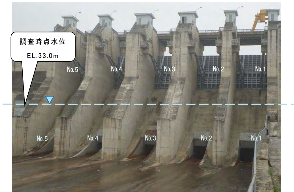
図 2-6 ターチャックダム洪水吐き部下流面状況
