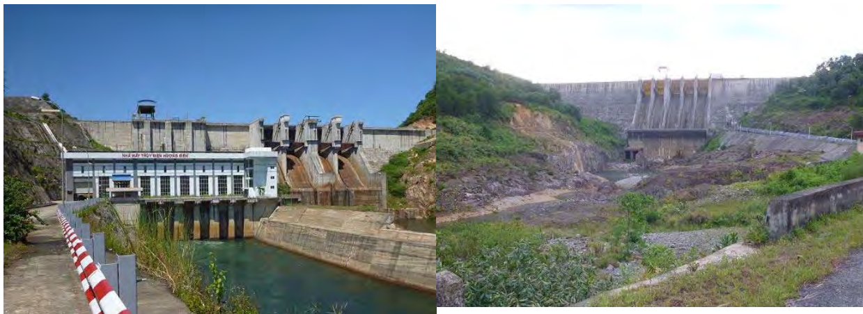
フォンディエンダム(左)とビンディエンダム(右):これら 2 つの電力ダムは、大雨が予想されるときに予備放流を行い貯水位を下げ、洪水を貯めて下流の水害を減らすこととしているが、流域の情報が無く的確に運用できていない。
