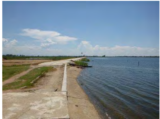
P4 水位計設置予定場所
