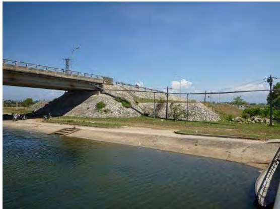
C1 CCTV 予定場所
