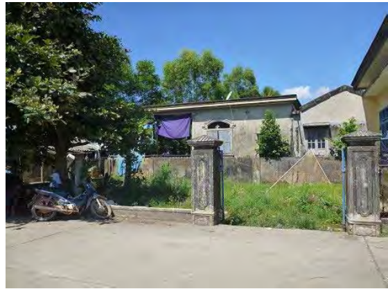
C14 CCTV 予定場所
