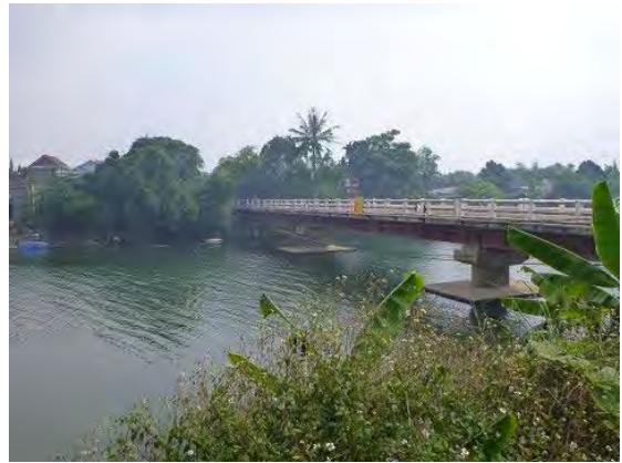
P9 雨量・水位観測所予定場所廻り写真
