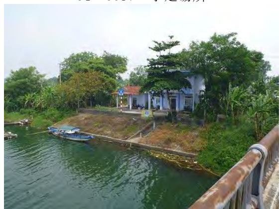
C6 CCTV 予定場所
