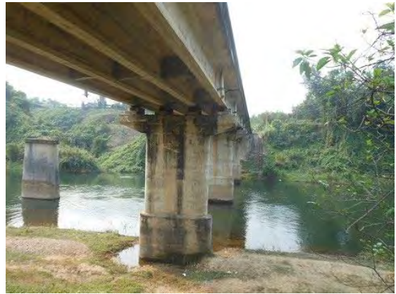
P8 水位計設置予定場所
