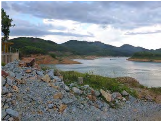
C11 CCTV 予定場所
