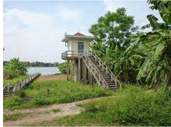
既設水位観測所
