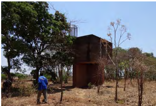
既存高架水槽(50m 3 /使用していない)
