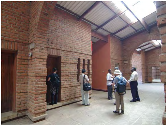
既存管理ブロックの廊下
