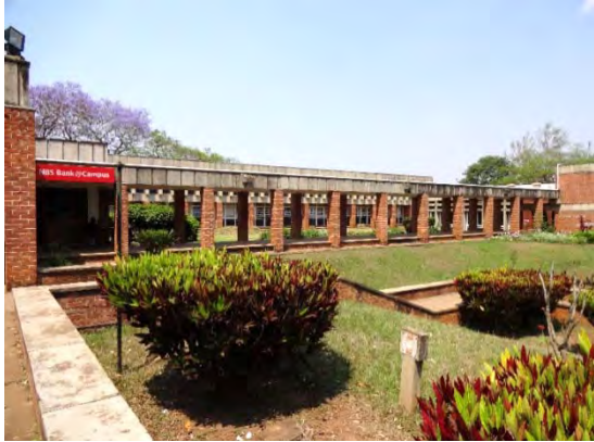
管理棟エントランス
