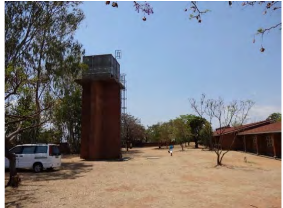
既存高架水槽(2004年無償供与付属中学校用)
