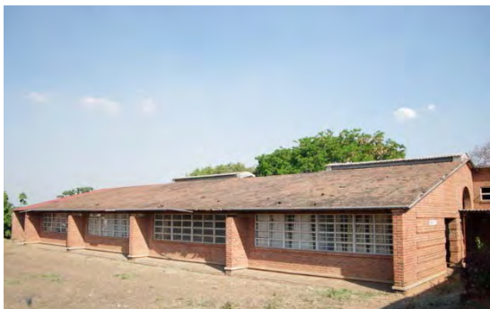
既存構内施設は煉瓦造平屋、屋根は鋼板シート上に煉瓦タイル
