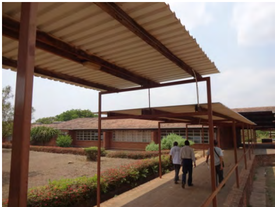
構内施設を結ぶ渡り廊下
