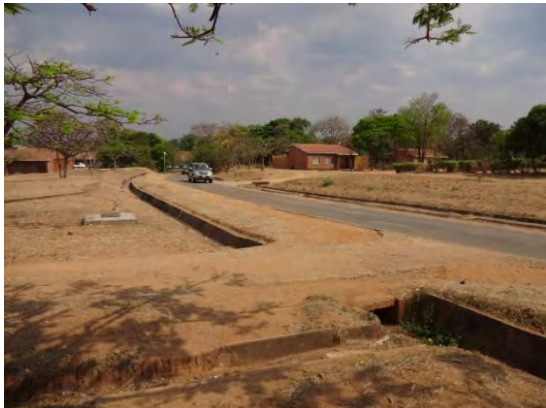
敷地状況 3 構内道路 左:多目的ホール 右:教職員住居
