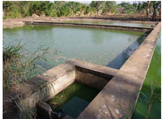
既存污水处理池
