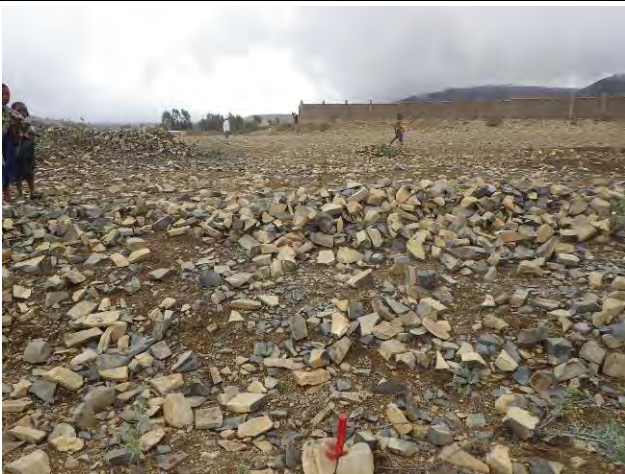
No. 3 建設サイトには多数の石があり、地盤もスレート層岩盤となっている。
