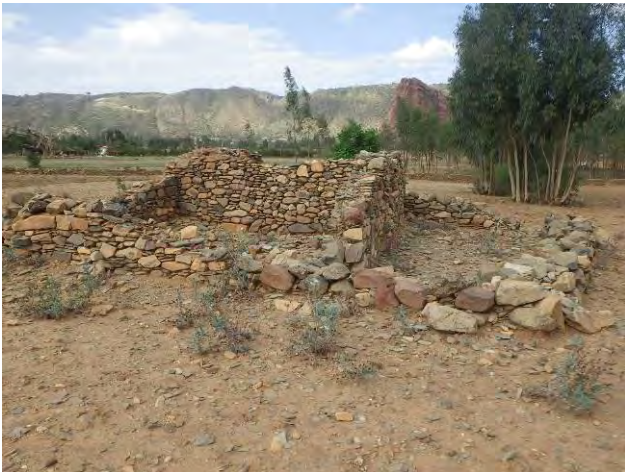
No. 2 建設サイト内には石積みの建物があり、エチオピア側負担で撤去が必要となっている。
