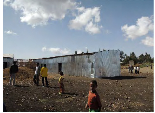
No. 1 サイト内に仮設校舎を建設し、学校運営を開始している。
