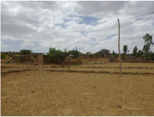
No. 5 建設サイト内を電柱・電線が横切っている。
