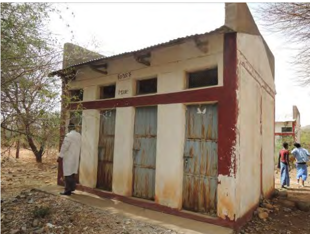
トイレ外観 (No. 8 と同じ学区内にある中学校、Ras Alula Baneg Lower Secondary School)
