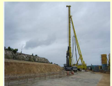
Sitio de construcción de dique subterráneo Nakahara
