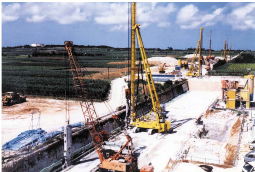
Construcción de diques subterráneos continuos en la Isla Miyako (Fuente : Revista de Diques Subterráneos (Recursos Verdes 03) )
