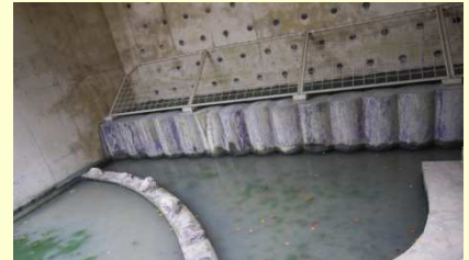
Instalación en dique subterráneo Komesu
