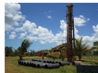
Perforaciones exploratorias (Artemisa)
