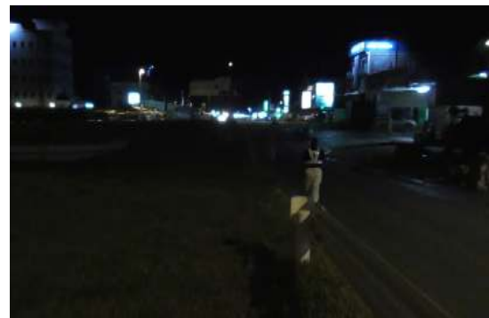
つばさ橋ベトナム側出入口： 左半分が緑地帯・三角島。向こうに照明、周りに商店の明かりがあるが、足元はかなり暗くなる。
