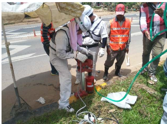
ピカロット設置のための縁石への穴開け
