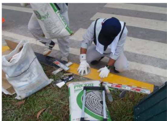
ピカロットの埋設
