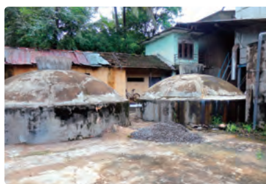
② 本事業の融資を利用した精米工場の廃水処理施設
