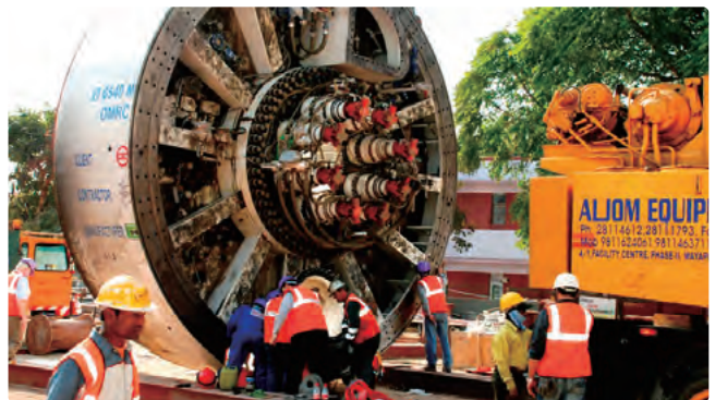
全断面トンネル掘進機の組み立て
