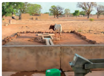
家畜水飲み場 (ポンプからこぼれた水が排水路をつたい流れる仕組み)
