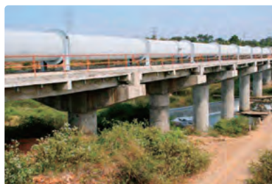
バンガロール市への送水管
