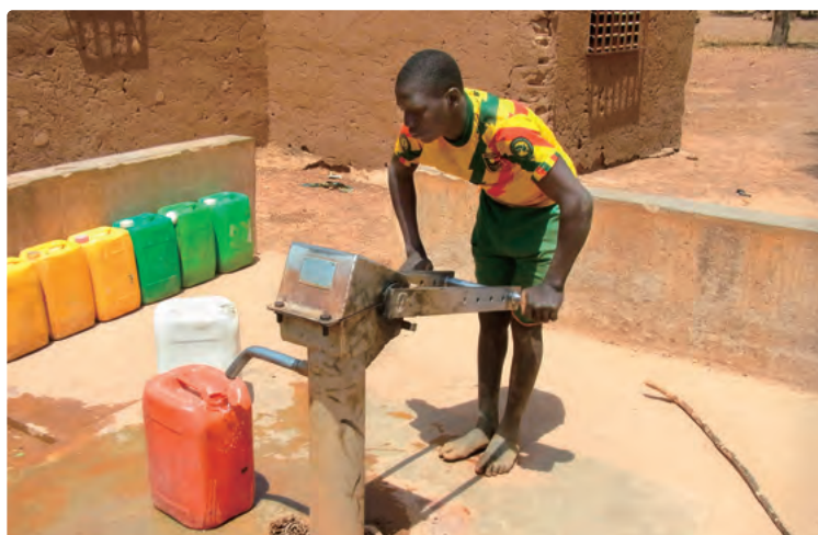
建設されたハンドポンプ付深井戸給水施設
