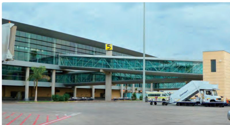
本事業で整備された旅客ターミナル
