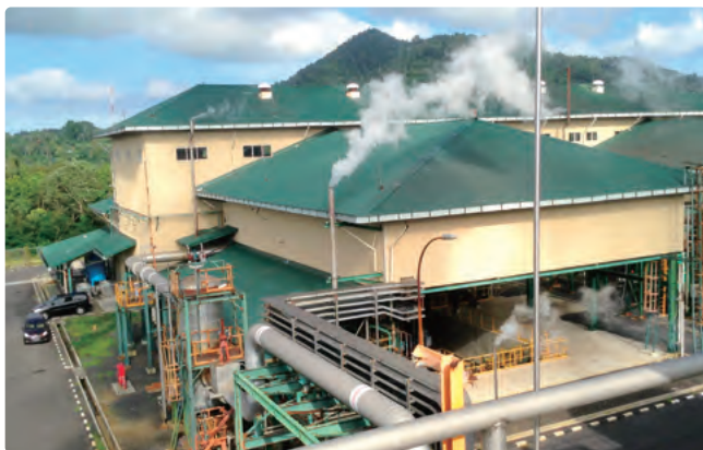
ラヘンドン地熱発電所
