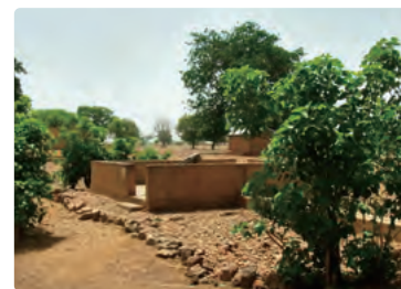
井戸周りの砂利敷および家畜除けのための生垣 (泥たまりや洗濯を避けるために住民により整備された)
