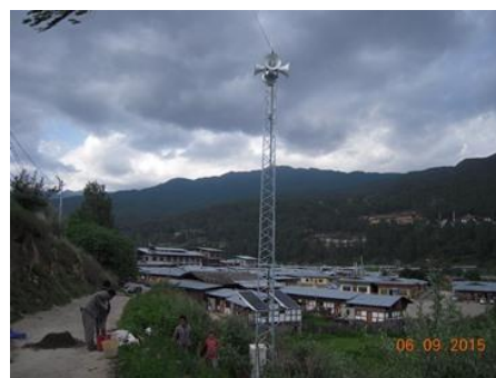
Bumthang Downtown 警報サイレン塔
