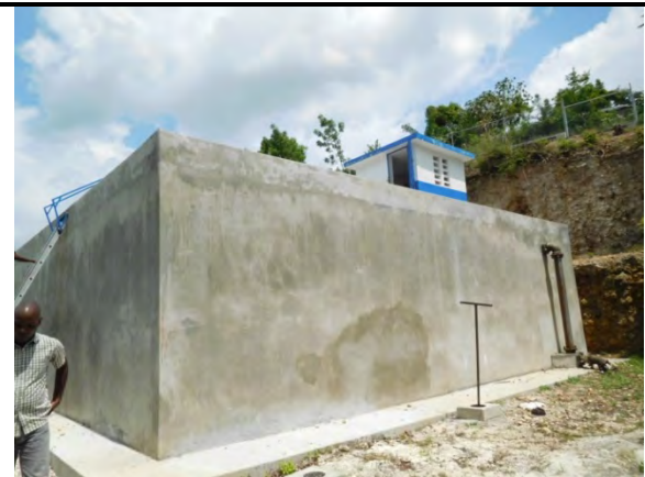
国家給水衛生局 (DINEPA) の貯水槽 新設サイト付近を管轄する。水源は湧水であり、貯水槽が満水とはならない程度の量。 (2016年8月10日)
