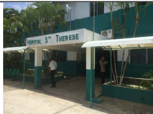
既存ミラゴアンヌ病院 エントランス前の風景。 (2016年7月22日)
