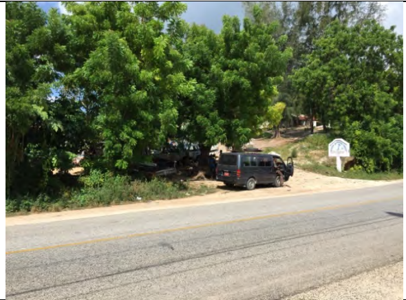
新設予定サイト入口 国道2号線沿いの入口。サイト内に住民の住居がある。 (2016年8月10日)
