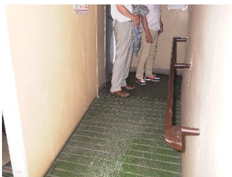
フィリピン国内介護施設例（廊下）
