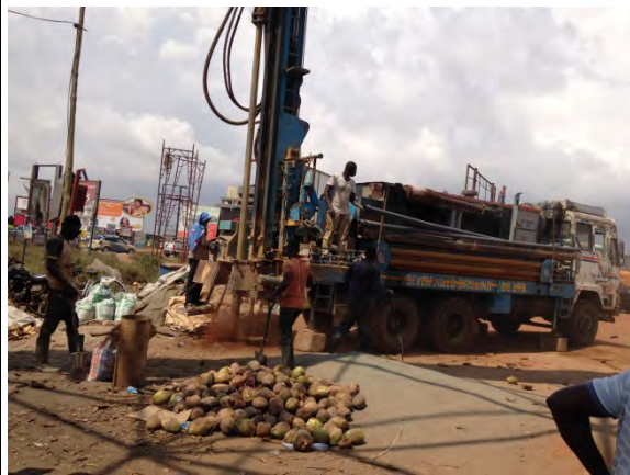
観測井の掘削状況
