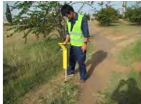
埋設物調査の状況
