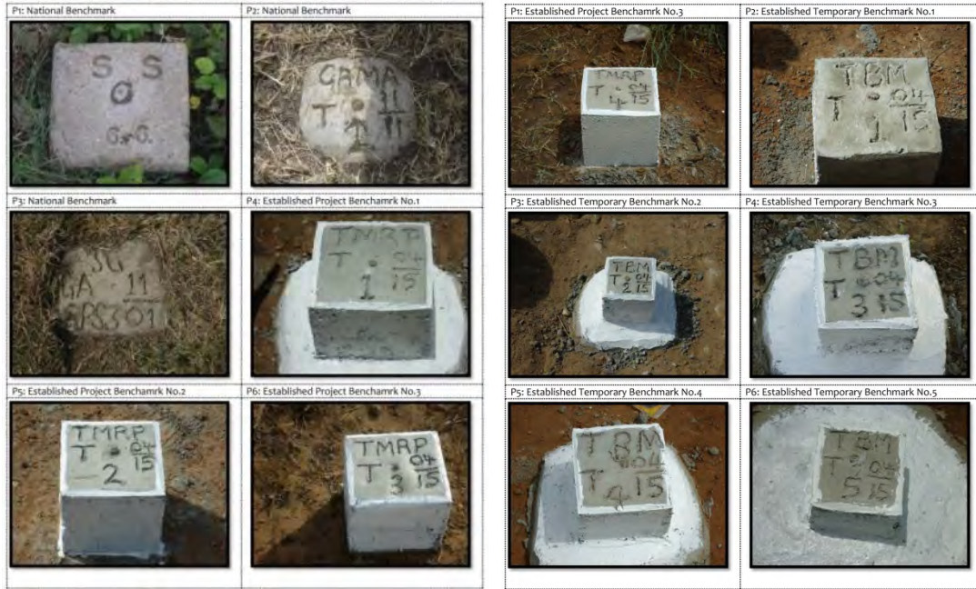
写真 2-2-2.1 設置したベンチマーク
