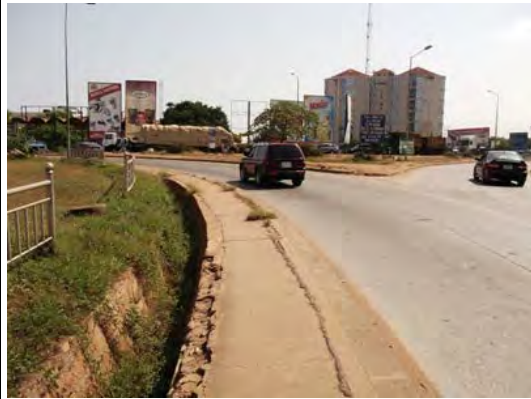
ラウンドアバウトの環道状況
