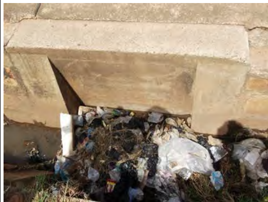
排水施設状況
