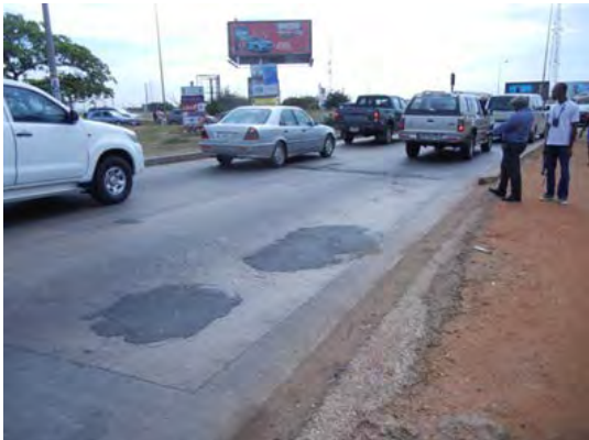
Motorway 舗装の状況
