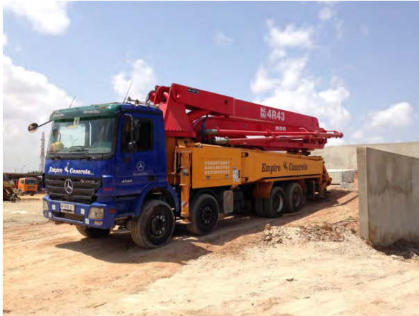
コンクリートポンプ車
