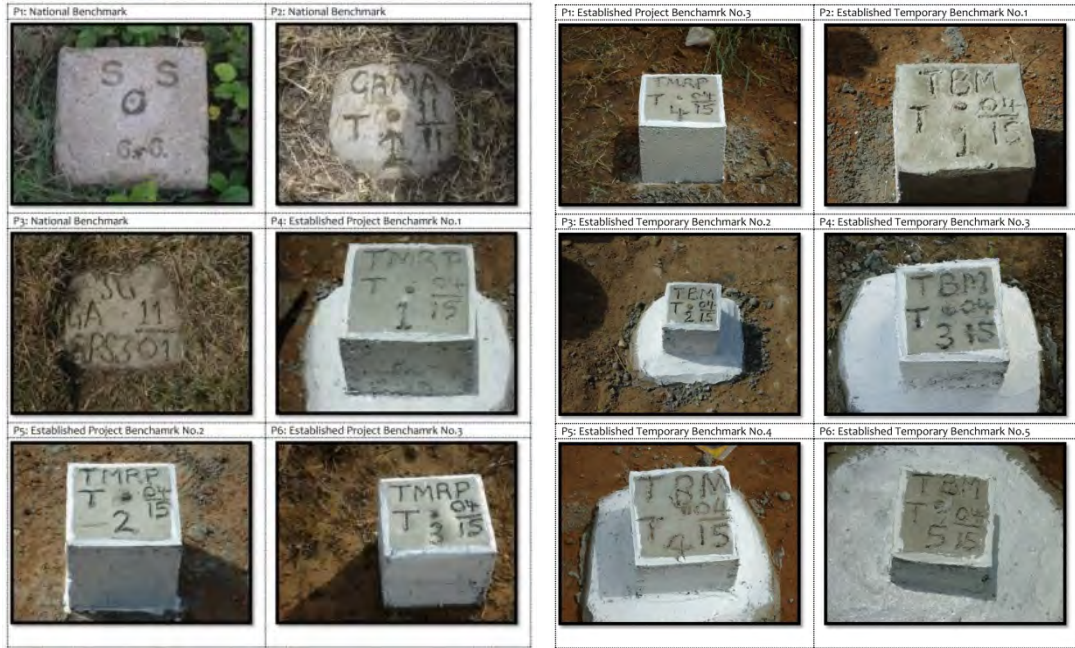
写真 2-2-2.1 設置したベンチマーク
