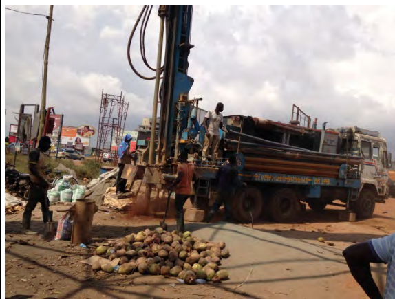
観測井の掘削状況
