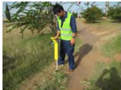
埋設物調査の状況
