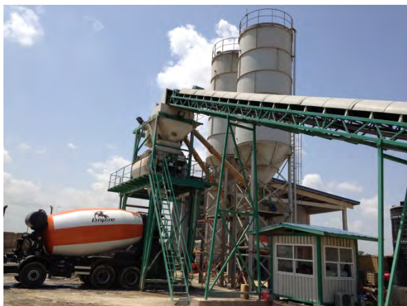
写真 3-2-5.1 稼働中の生コン工場
