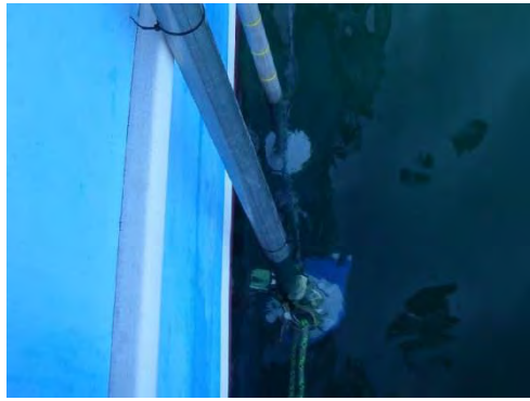
DHSDAS (下), SBES (上) 送受波器の取付状況
