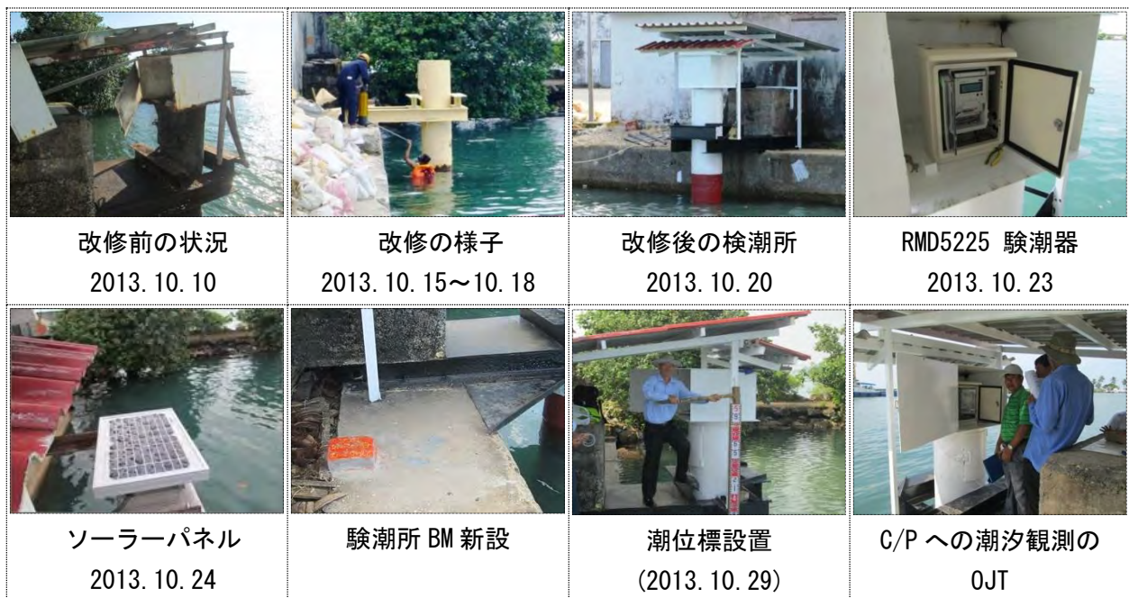
写真 2-5 験潮所の改修作業の状況写真
