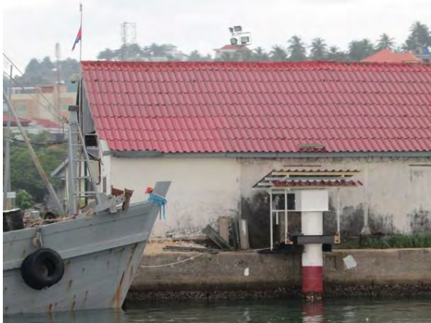
改修した験潮所の遠景
