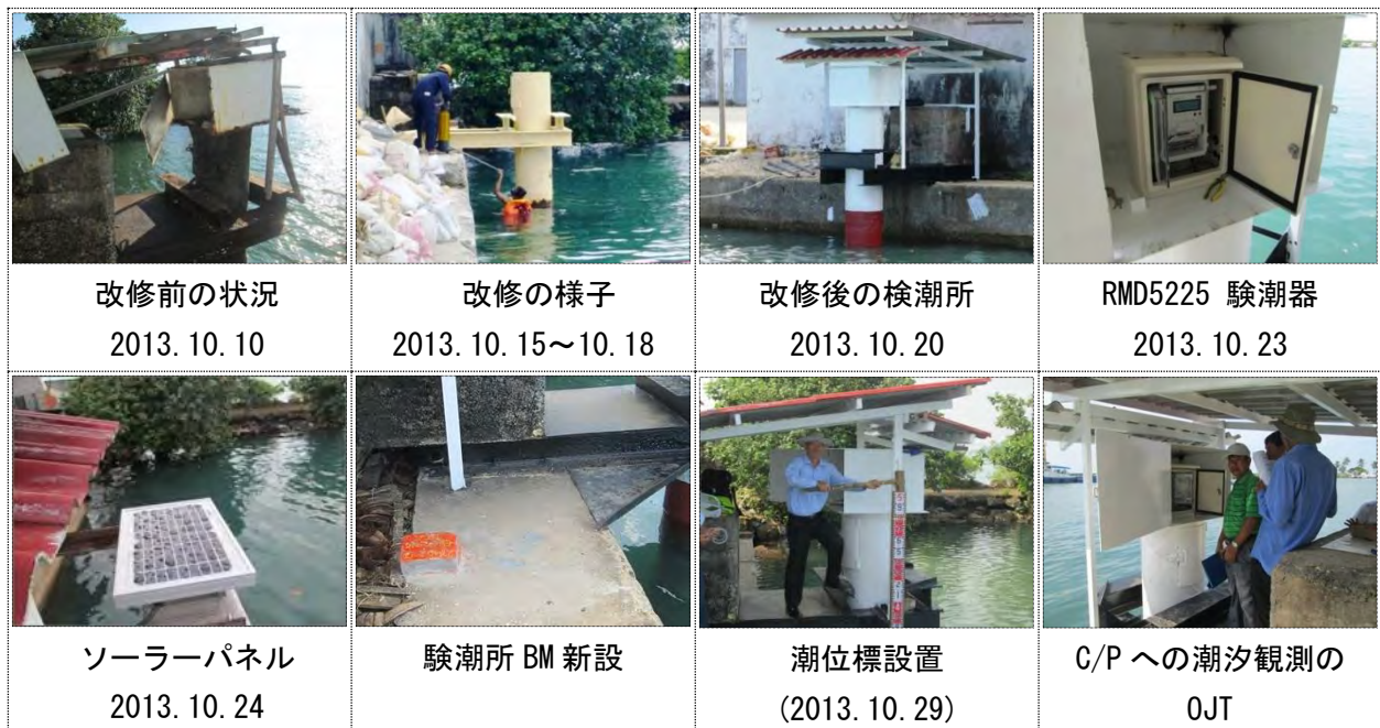
写真 2-3 験潮所の改修作業の状況写真
