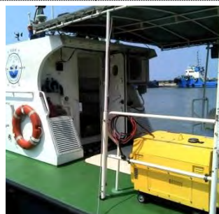
エアコン(ドア奥)と発電機
