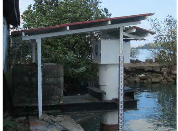
改修した験潮所の近景
