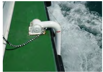
トランスジューサーのケーブルはパイプの中を通している
