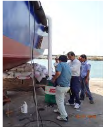
写真3-8 測量船(PAS Patrol Boat: KAOH Dekkol)に送受波器の取り付け
