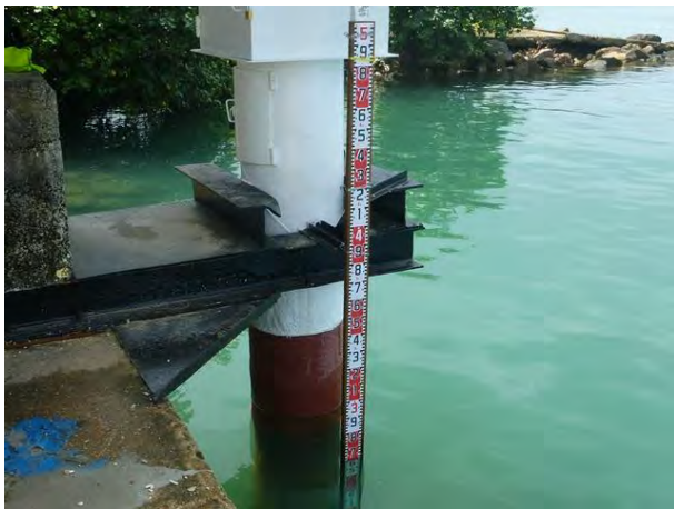
潮位標の設置
