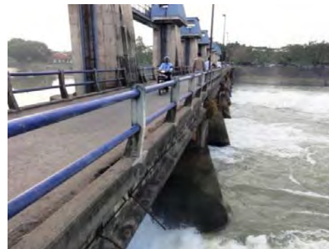
New Lengkong Barrage
