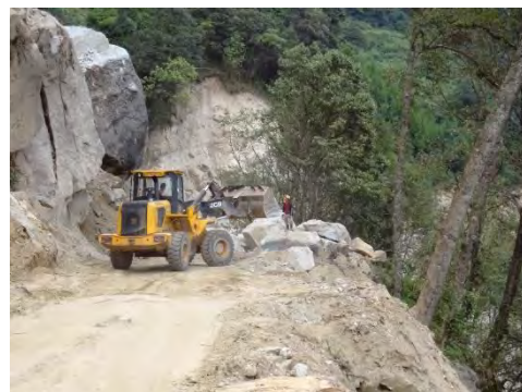
道路の落石を除去するブルドーザー
