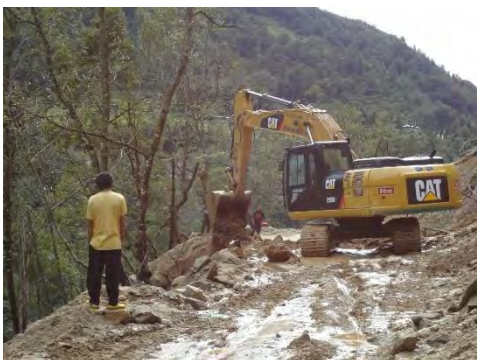
道路の落石を除去する重機
