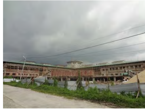
建設中の新 GRRH：外観
