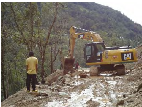
道路の落石を除去する重機
