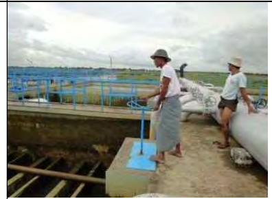
写真-21 ろ過池洗浄風景
