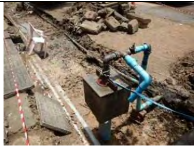
写真-67 配水管に地下水を接続
