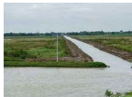
写真-1 導水路（開水路）
