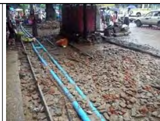
写真-72 管布設状況
