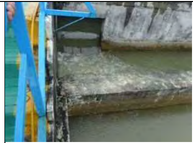
写真-15 フェーズ2におけるフロック形成池出口
