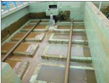
写真-22 ろ過池洗浄
