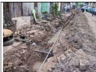
写真-70 管布設状況
