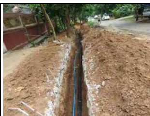
写真-71 管布設状況
