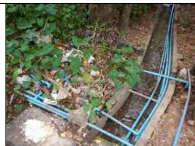
写真-63 地上の給水管
