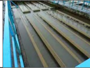
写真-28 沈殿池出口集水装置 (2014.2.25)
