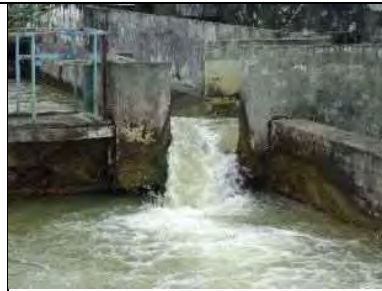
写真-14 フェーズ1におけるフロック形成池出口
