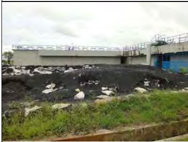
写真-25 アンスラサイト保管状況
