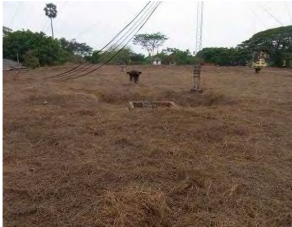
写真 7-1 配水池の頂部外観
