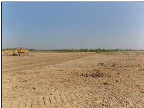
浄水場建設用地
