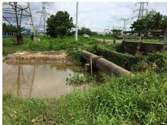
鉄塔脇の既設管 φ600mm
