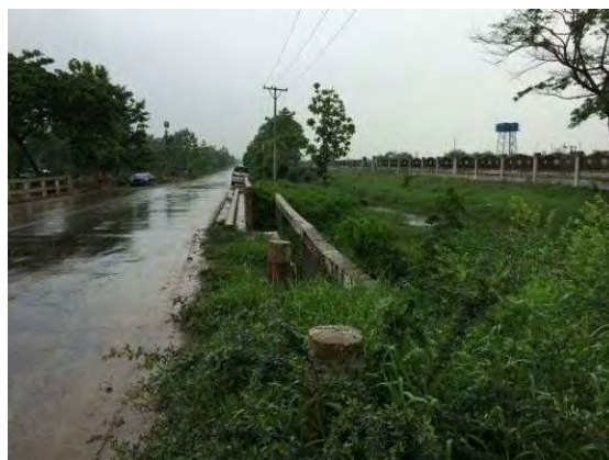
国道 5 号線北側
