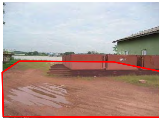
写真 5-10 発進立坑用地
