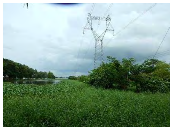
国道 5 号線南側
