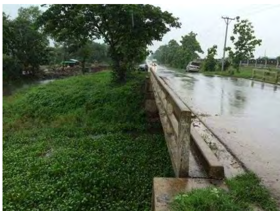
国道 5 号線南側
