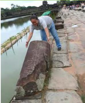
写真-3: 西参道には3tを超える石も多く、重機なしでは移動が非常に困難である。石は壊れやすいため、安全で確実な移動手段が必要である。
