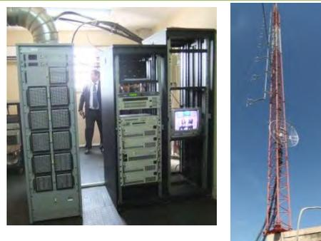
写真-6：市内の別の施設、社会保険院ビルに設置されている送信器（左機器：アナログ、右機器：デジタル）とアンテナ。放送番組はここから送信される。
