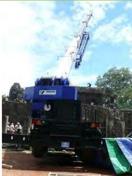
写真-5: 日本政府アンコール 遺跡救済チーム (JSA) が修復を行うアンコール遺跡バイヨンでは、30t 吊りのホイールクレーンが使用されている。
