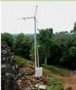
写真-7: 米 NGO の WMF が修復を行うアンコール遺跡ブノンバケンでは2.5吊りと2.8t吊りの自立式クレーンが使用されている。
