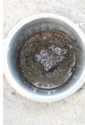
2 P11、底の表面ははがされていて、鋼床版の錆が見える。
