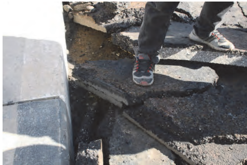
5. 北側地覆付近の錆状況。
