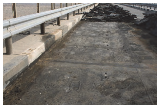
6.主塔付近での舗装撤去後の状況。
