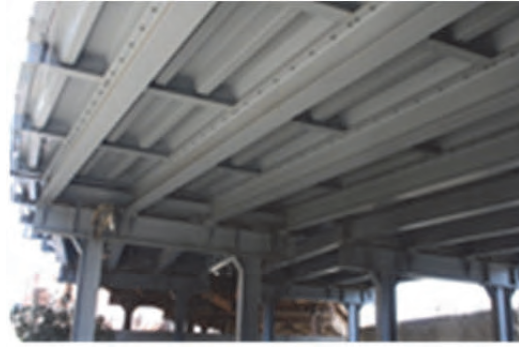
2. Masara 橋の鋼床版構造は、スエズ運河橋のものと類似している。
