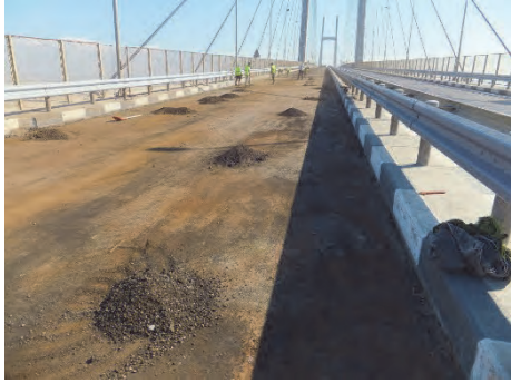
1. 北側西サイド橋梁半分の測定範囲。
