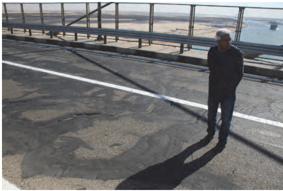
1. 南側の大きな舗装クラック。ダイヤフラム D58 付近。 .
