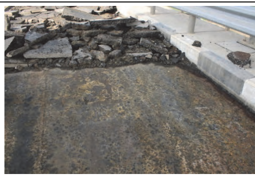
西側主塔近傍の錆状況。このあたりが最も錆が多い区間と思われる。
