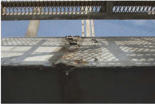
9. フェアリングの錆
