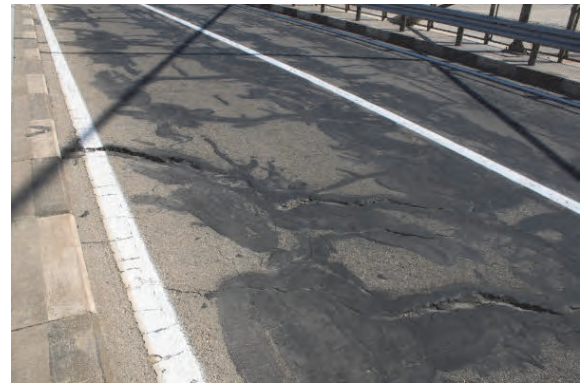
2. 南側の大きな舗装クラック。
