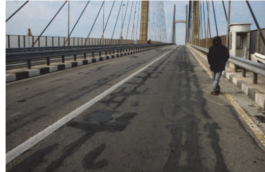
2. 走行車線で、5線の補修が確認される。これらはUリブの中央および、Uリブ間に一致する。
