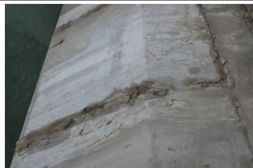
フェアリングの錆は構造上問題ないが、錆を除去し補強することが望ましい
