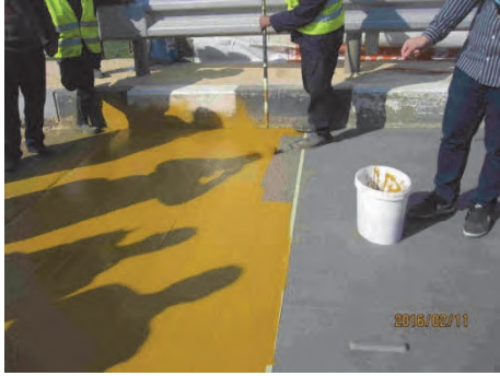
5. ローラーによるプライマー塗布
