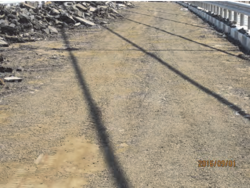
鋼床版表面 (清掃前)
