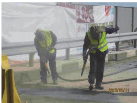
1. サンドブラストの試験施工
