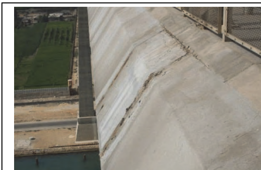
現場溶接部のフェアリングに甚大な錆が発生している
