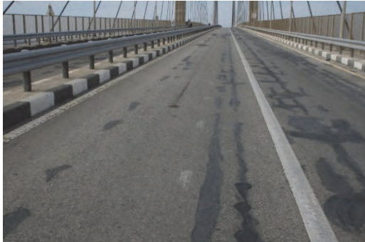
1. 北側車線の東側。西側を望む。舗装の補修状況が確認される。
