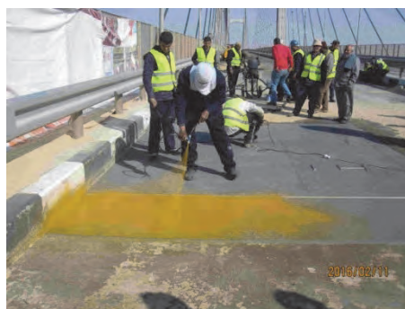
4. スプレーによるプライマー塗布
