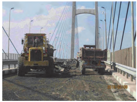
2. 撤去舗装の搬出。
