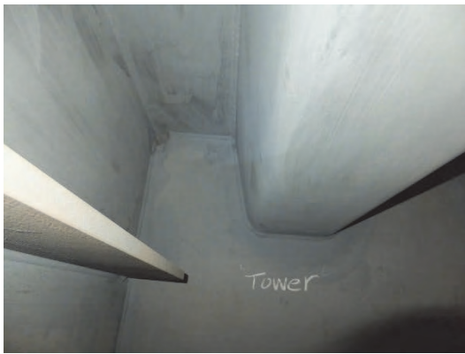
3. 南側 D30、R8 Uリブの状況。ペンキのクラックは発生していない。
