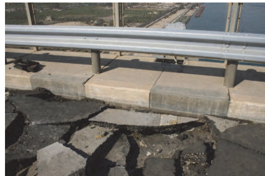
6 P13、撤去され t 舗装と舗装上のキャップ
