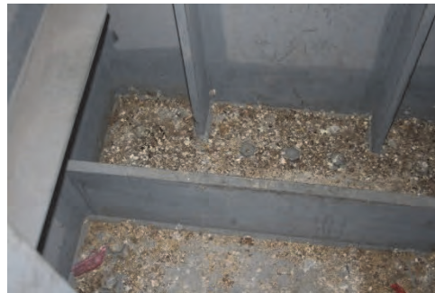
6. 箱桁の入り口。鳥の糞が散乱している。
