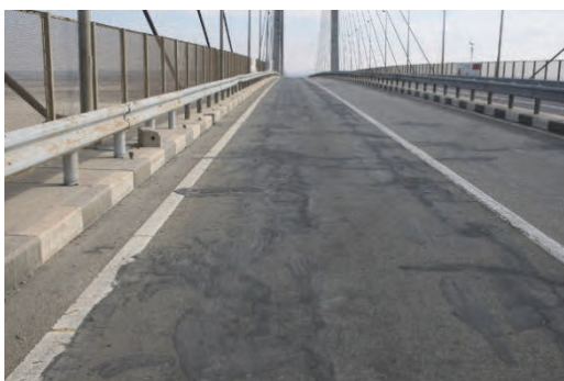
5. 橋梁中央付近の舗装補修状況。
