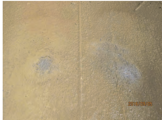
清掃後の測定予定点
