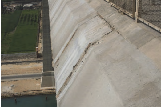
7. 現場溶接部のフェアリングに甚大な錆が発生している
