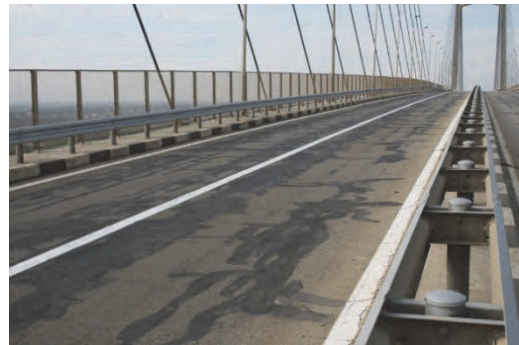
4. 南側の舗装補修状況。
