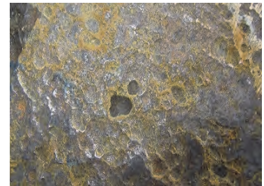
鋼床版表面（2012 年調査）
