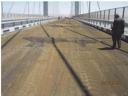
鋼床版表面 (清掃後)
