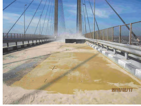
8. プライマーの塗布後
