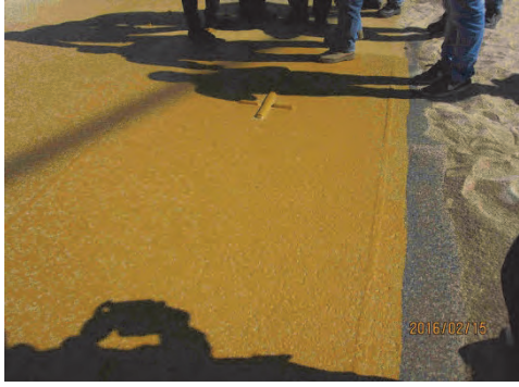
7. プライマーの塗布後
