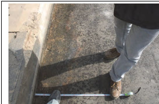
鋼床版の R4 U リブの溶接位置は路肩端から 64cm で写真の沓の位置である。
