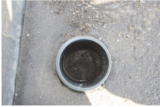
1 P11、水が確認できる。底は膨れ上がっている。
