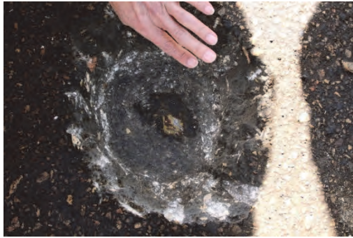
3. 舗装状況はかなり良好である。鋼床版の上面に錆は確認されない。鋼床版の黄色の部分プライマーの Zinc Chromate である。
