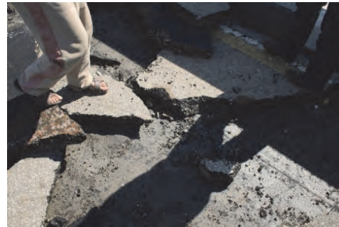
6. 車線中央部状況。錆は発生していない。
