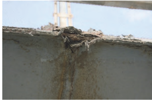
10. 大きな錆による損傷
