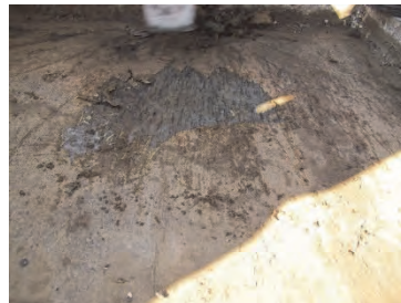
鋼床版の錆（2012 年調査）
