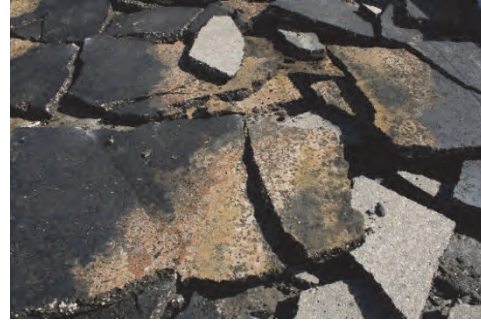
4. 撤去舗装の裏面が赤いのが、錆の発生を示す。
