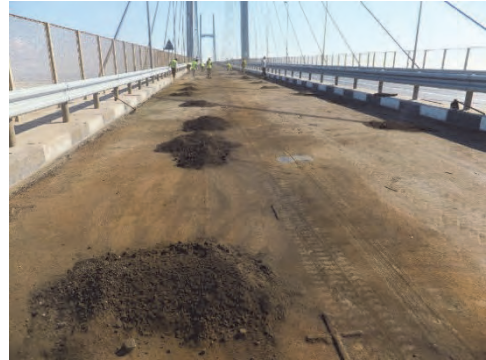
2. 白い部分は比較的良好。錆は両サイド及び中央に多く発生している。
