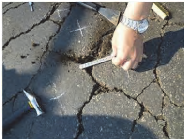
舗装のクラック（2012 年調査）
