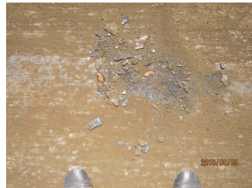
大きな錆 (清掃後)
