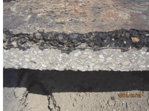
舗装切断面 (鋼床版から 2cm 上まで)
