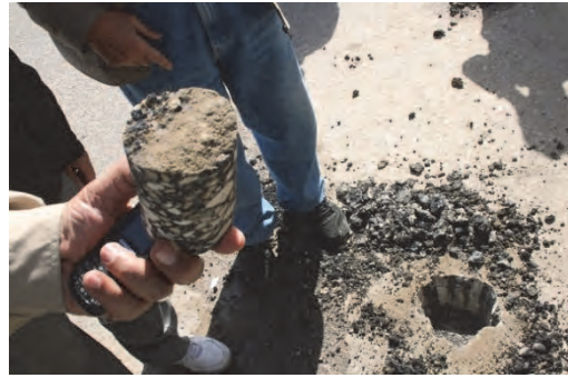
4. コア抜きされた舗装。良好である。
