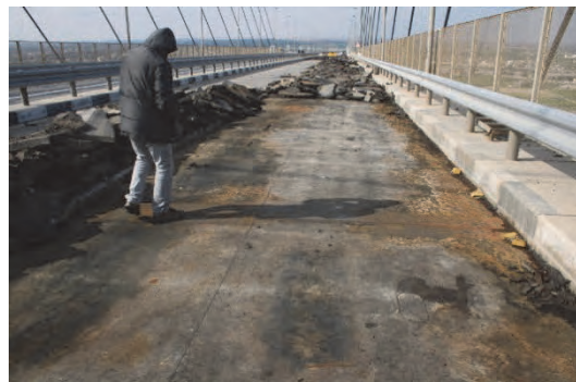
錆の発生位置は舗装クラックの発生位置の両サイドである。中央部分は良好である。
