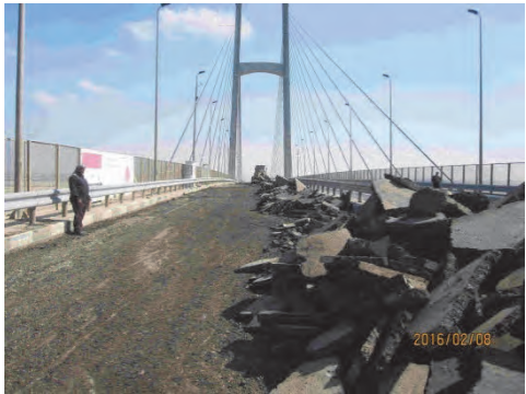
1. 北側西サイドの舗装撤去。
