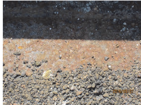
南側道路端の錆 (清掃前)
