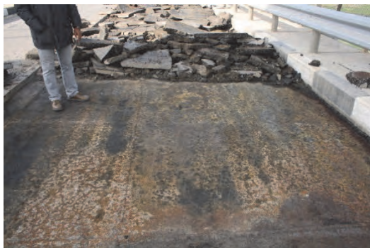
北側車線、西側主塔近傍の錆
