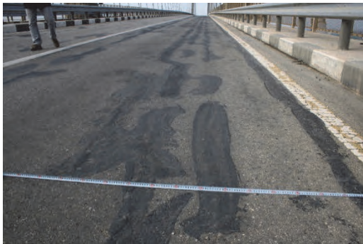
3.ここでは、車線端部に舗装修正が確認され、これはR4リブの中央に一致する。しかしながら、走行車両のタイヤ位置とは一致しないため、原因は不明瞭である。
