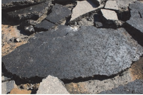
3. 北側西再度の撤去舗装。黒い表面は鋼床版に錆が発生していないことを示す。
