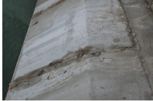
8. フェアリングの錆は構造上問題ないが、錆を除去し補強することが望ましい
