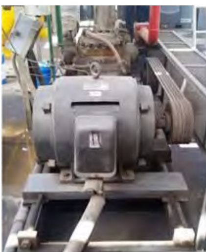
Compresores recíprocos muy antiguos de baja eficiencia.
