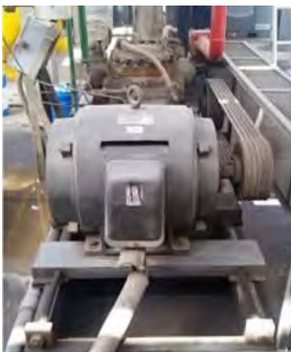
Compresores recíprocos muy antiguos de baja eficiencia.
