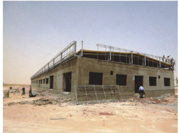
建設中の新研究棟
