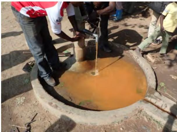
写真-5 : 揚水管が錆びて茶色い水が出ている既存ハンドポンプ給水施設。
