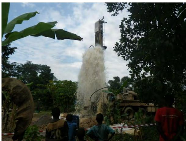
写真-11 : 試掘調査における孔内洗浄状況。
