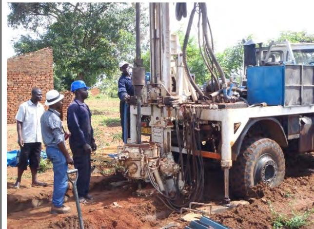
写真-12 : 地盤調査 (標準貫入試験) 状況
