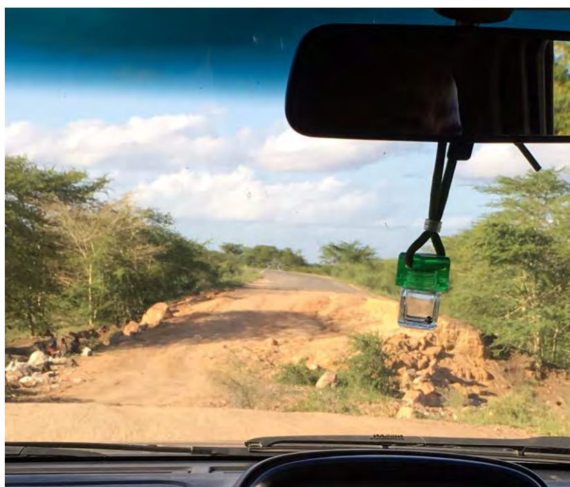
図 2 5 Chokwe 郡～Chibuto 郡間の道路の様子
