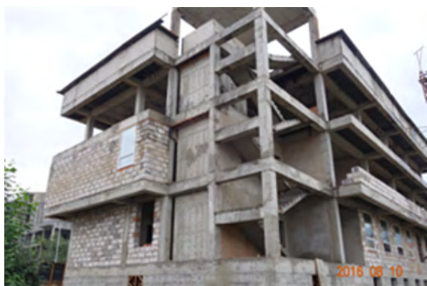
新実験棟 (建設中)
